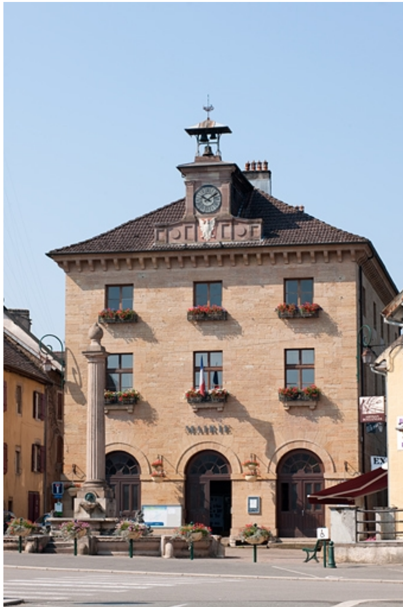
Façade antérieure de trois quart droit.
