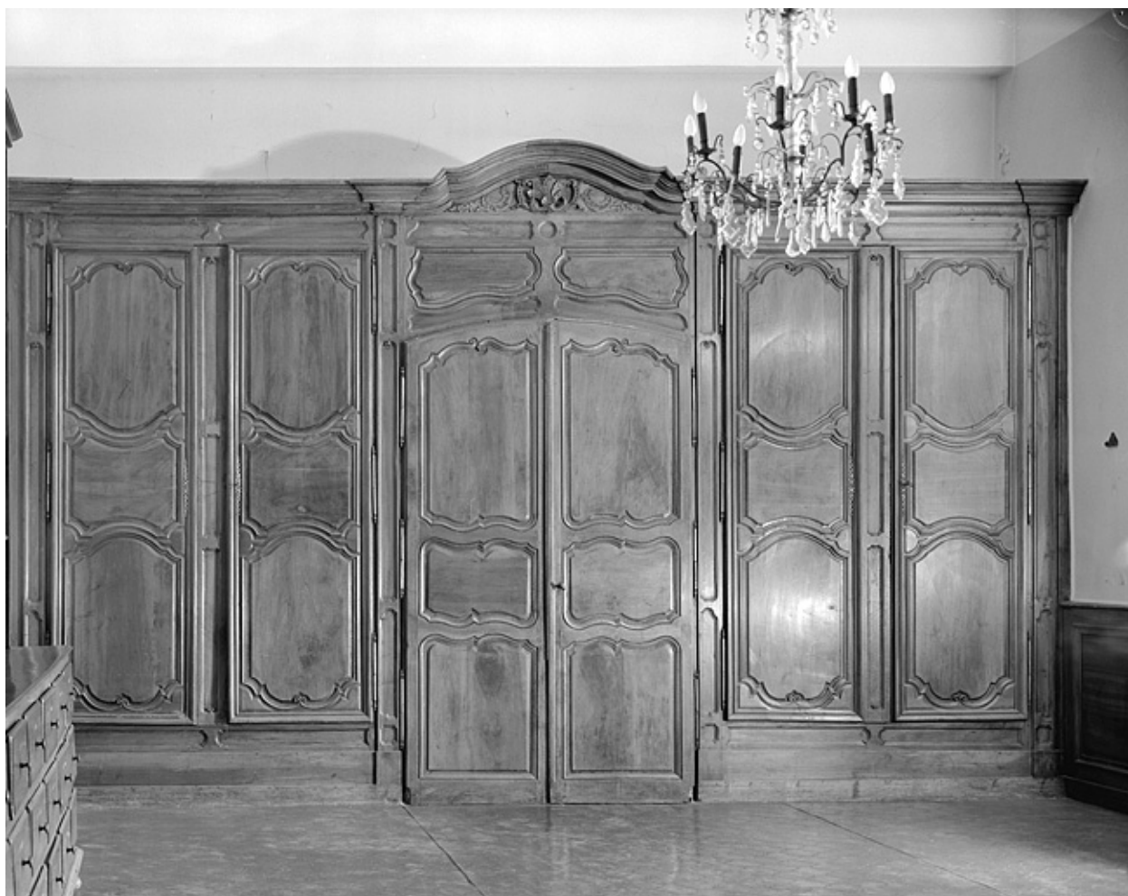
Placards et vantaux de la porte d'entrée.
