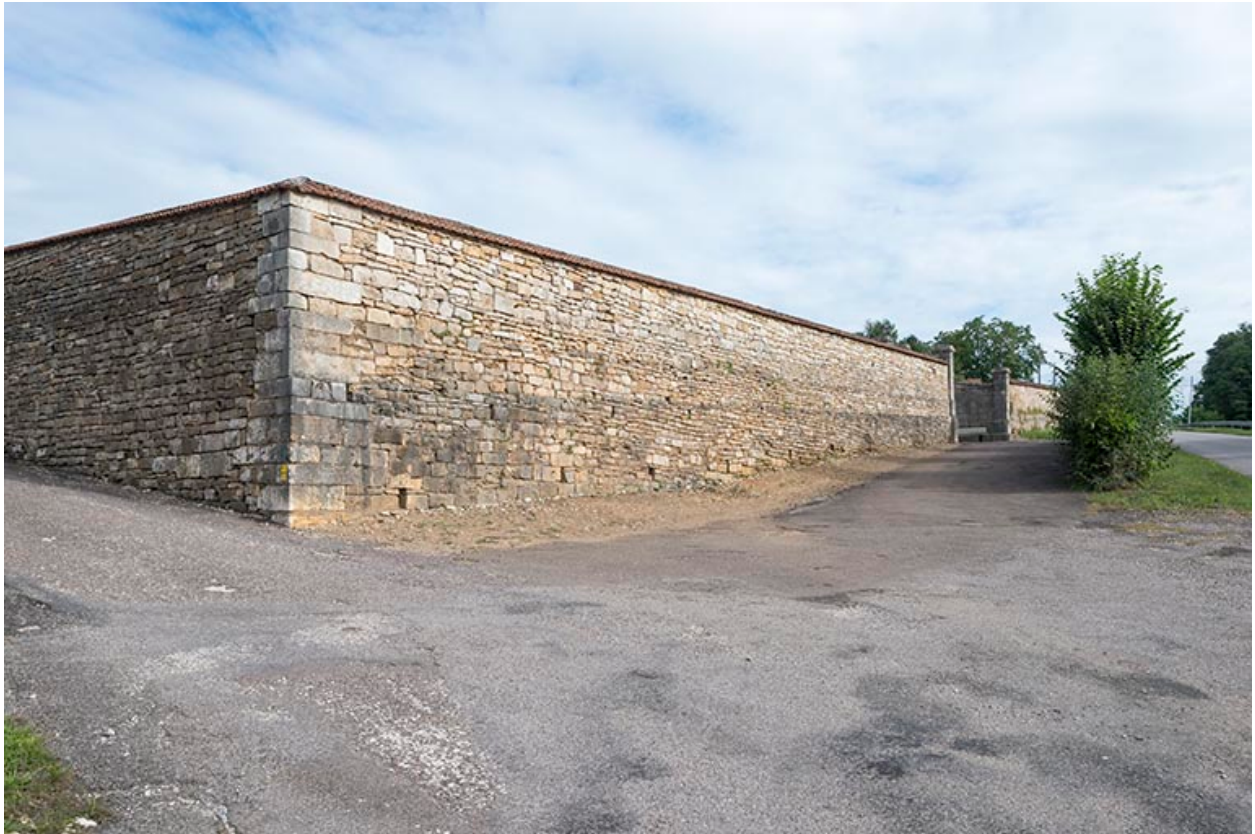
Le mur d'enclos du cimetière.
