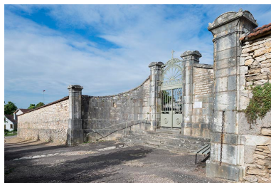
Vue depuis le haut de la rue. Phot. Jérôme Mongreville IVR43_20177000995NUC4A
