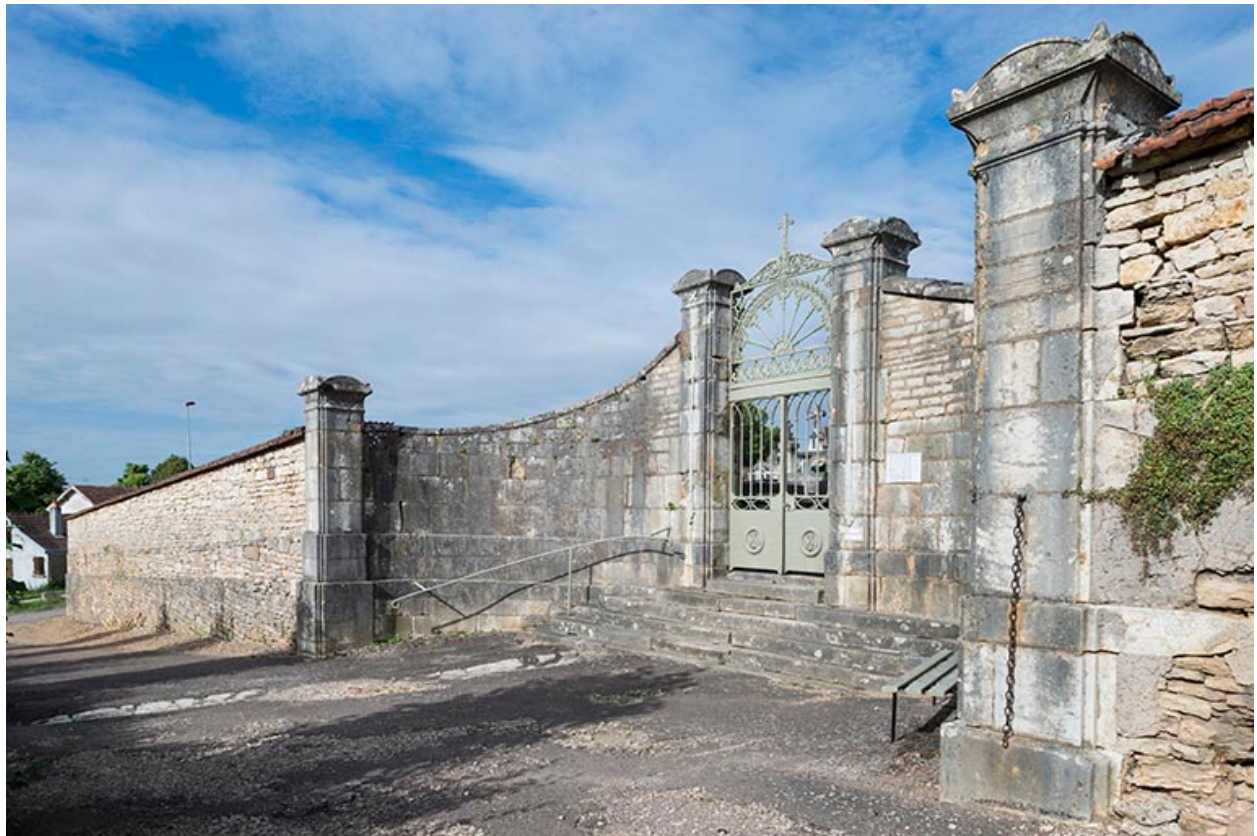
Vue depuis le haut de la rue.
