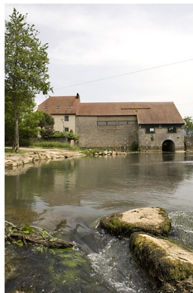
Façade ouest, depuis l'aval. Phot. Jérôme Mongreville IVR43_20087000601NUC2A
