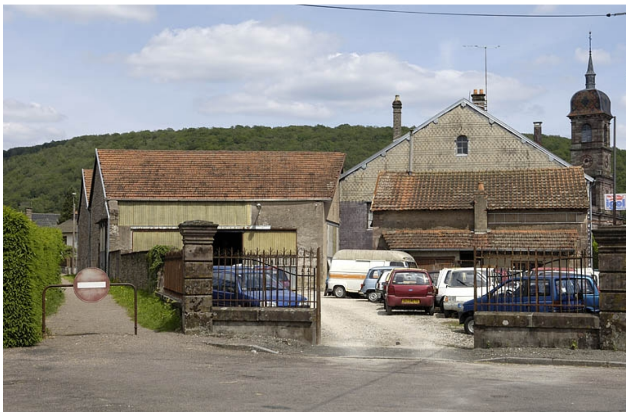
Atelier de fabrication et logement depuis l'ouest.
