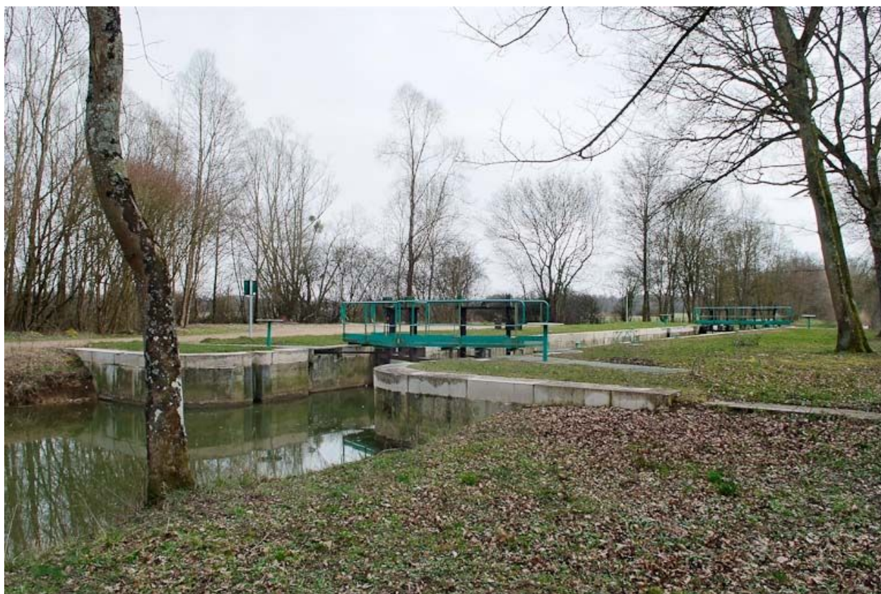
Tête amont de l'écluse.
