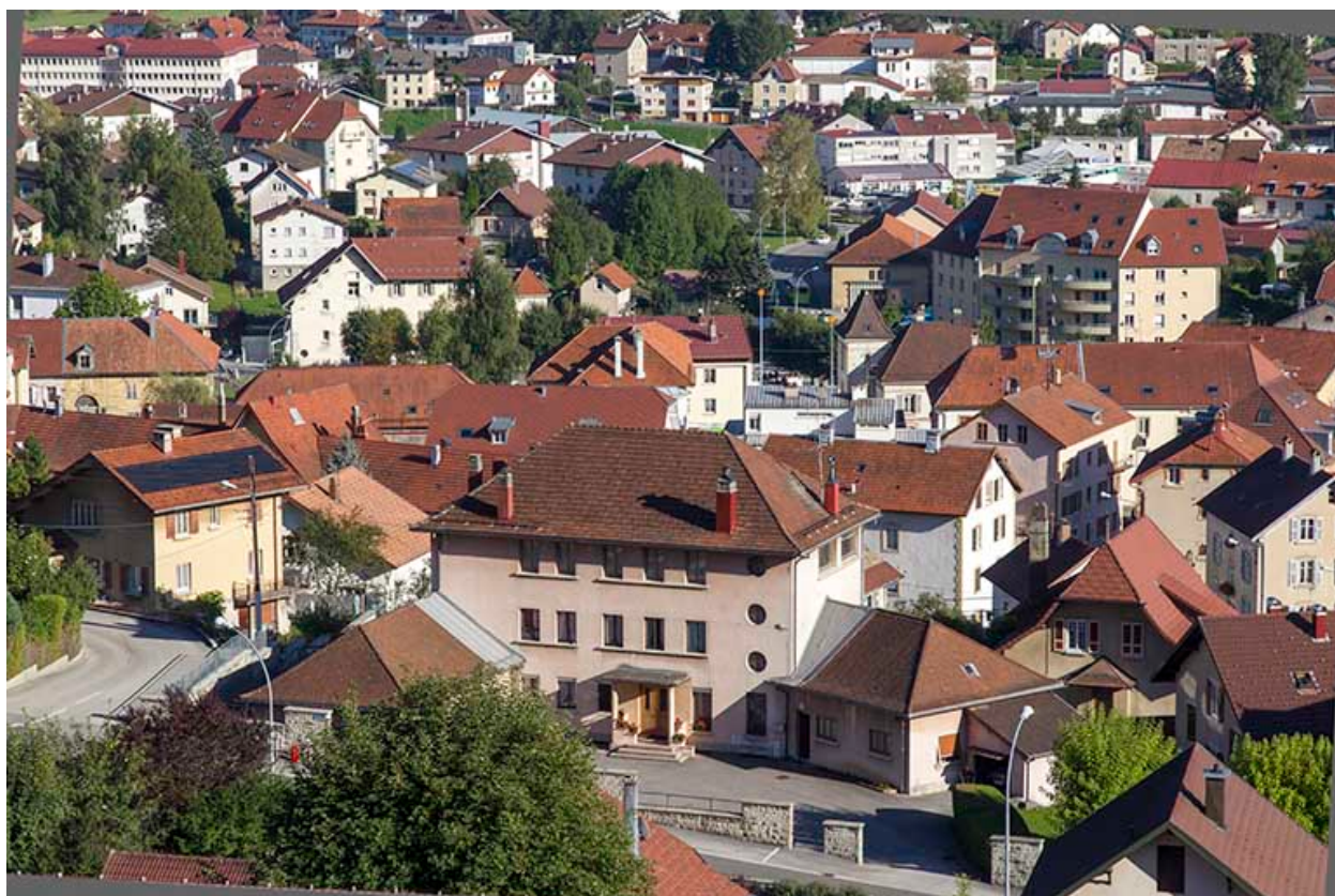
Vue d'ensemble plongeante, depuis le nord-ouest.
