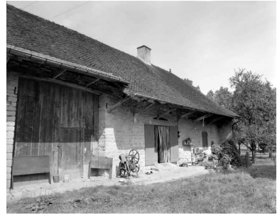
Partie droite de la façade antérieure. Phot. Dominique Dominguez IVR43_19773900085X
