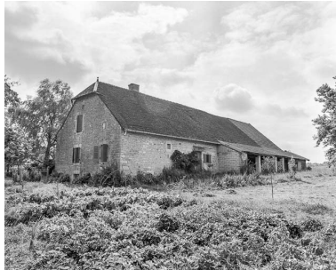
Façade postérieure et pignon droit. Phot. Dominique Dominguez IVR43_19773900086X
