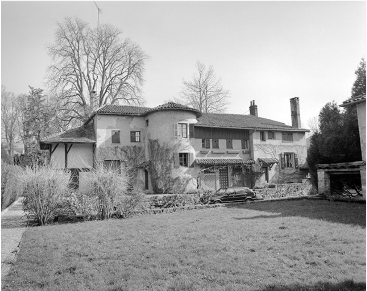
Façade antérieure du logement patronal (O).
