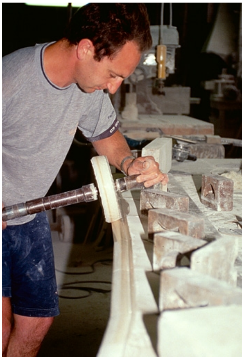
Polissage d'un limon d'escalier.
