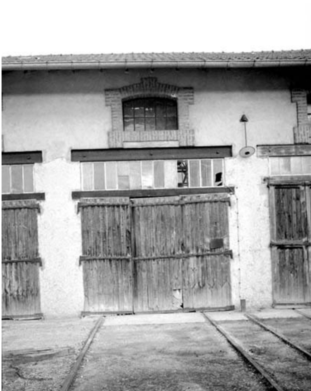
Détail d'une travée de la scierie.
