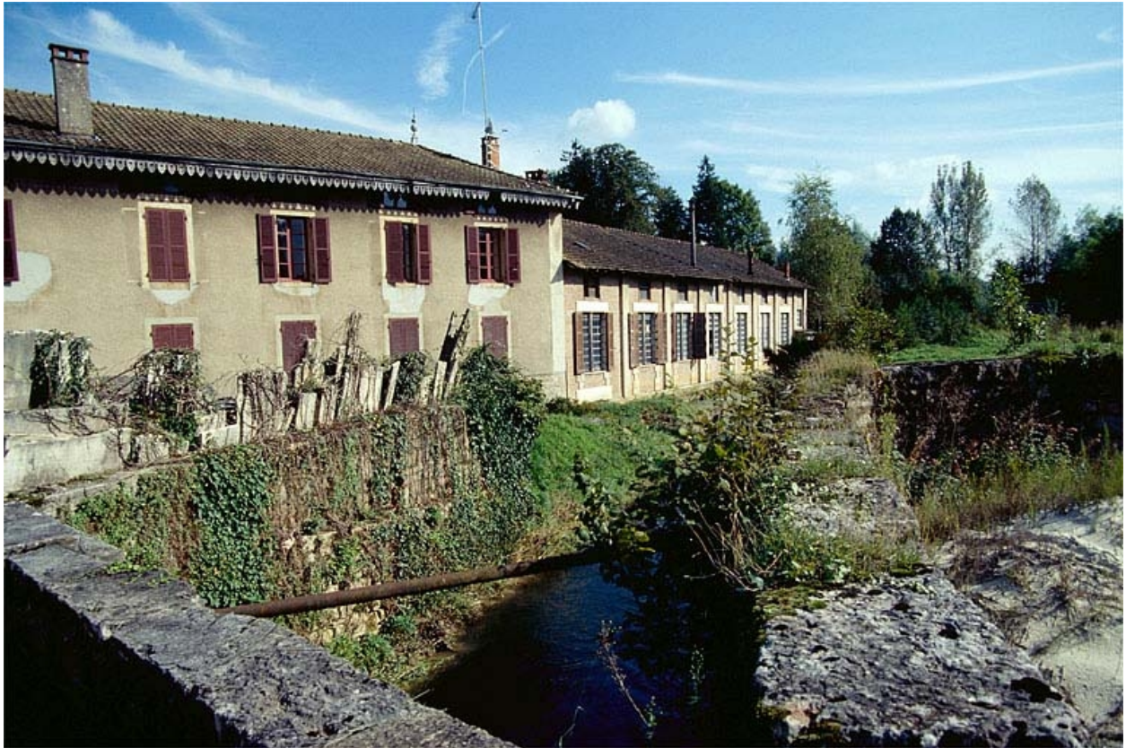
Logement patronal (H) et atelier des marbriers.
