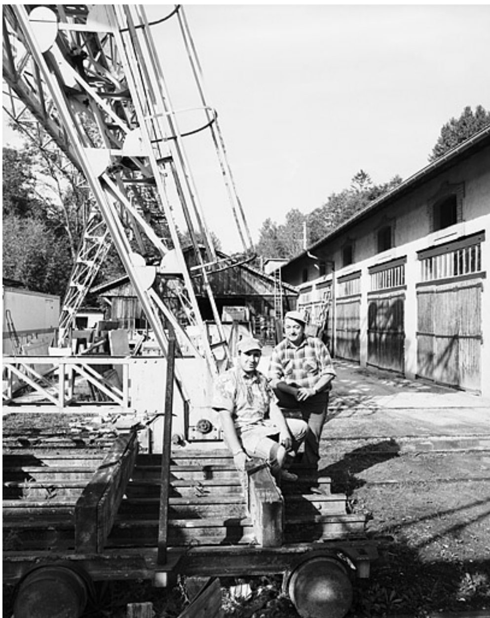
Ouvriers au pied du portique roulant.
