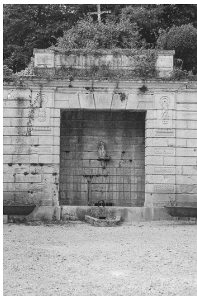
Vue de la partie centrale. Phot. Bernard Lardière IVR43_19797000160Z
