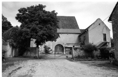
Vue d'ensemble. Phot. Bernard Lardière IVR43_19817000480Z
