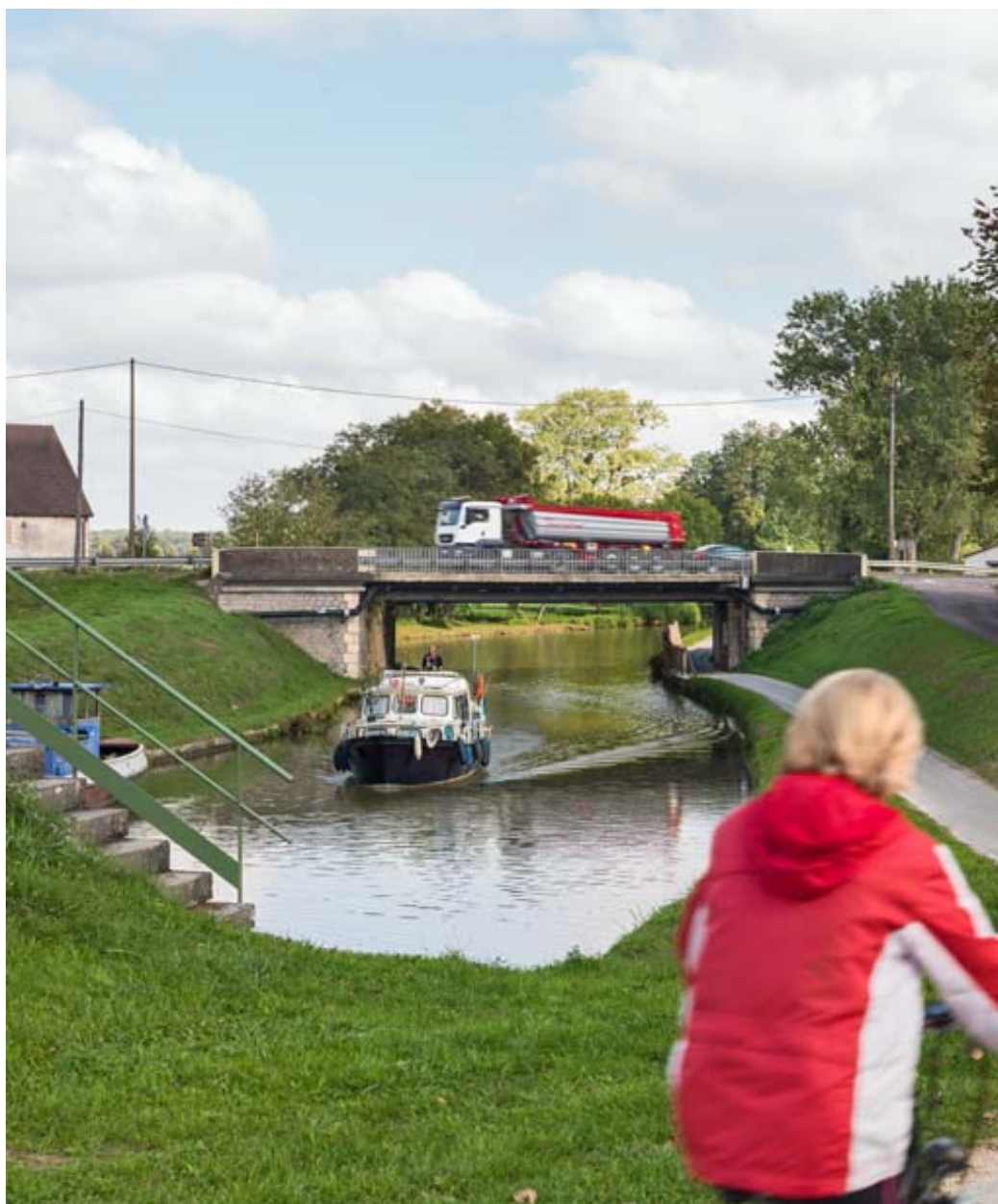
Vue d'ensemble du pont.
