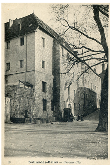
Salins-les-Bains - Caserne Cler, s.d. [début 20e siècle]. Phot. auteur inconnu IVR43_20243900216NUC4A
