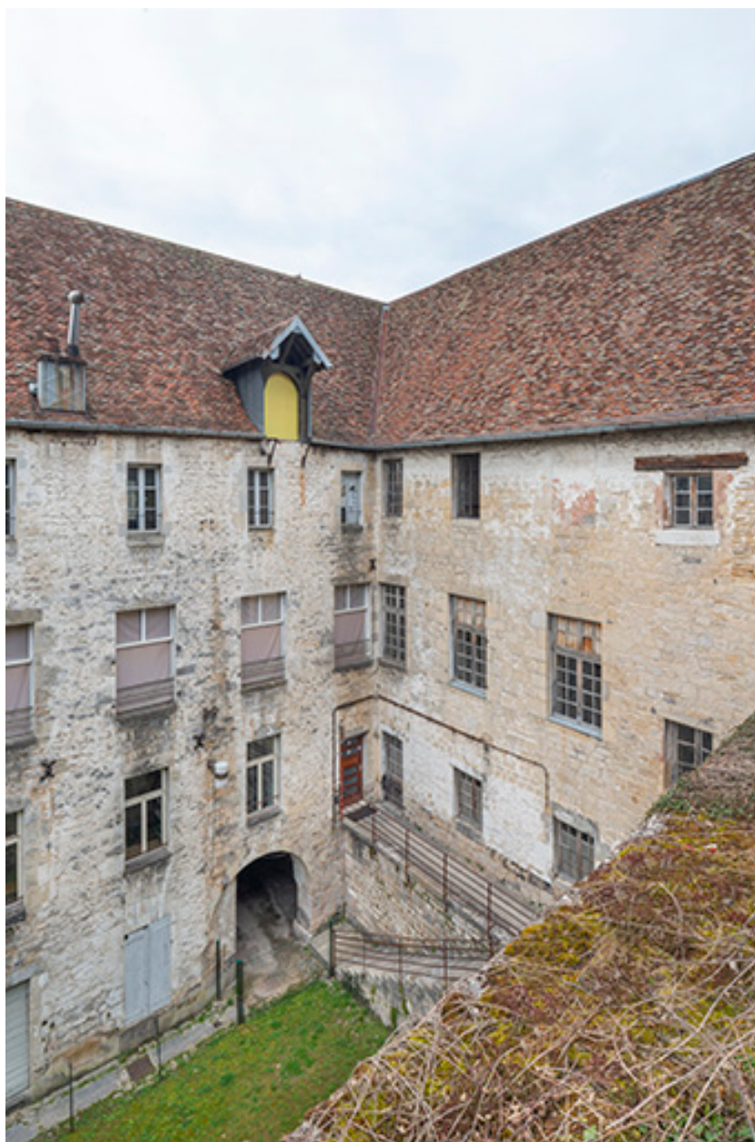
Partie nord des bâtiments sur cour.
