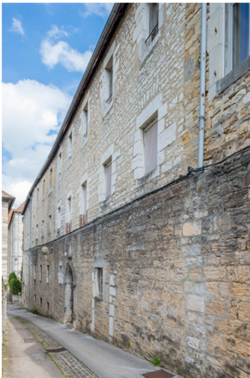
Elévation du bâtiment sur rue.
