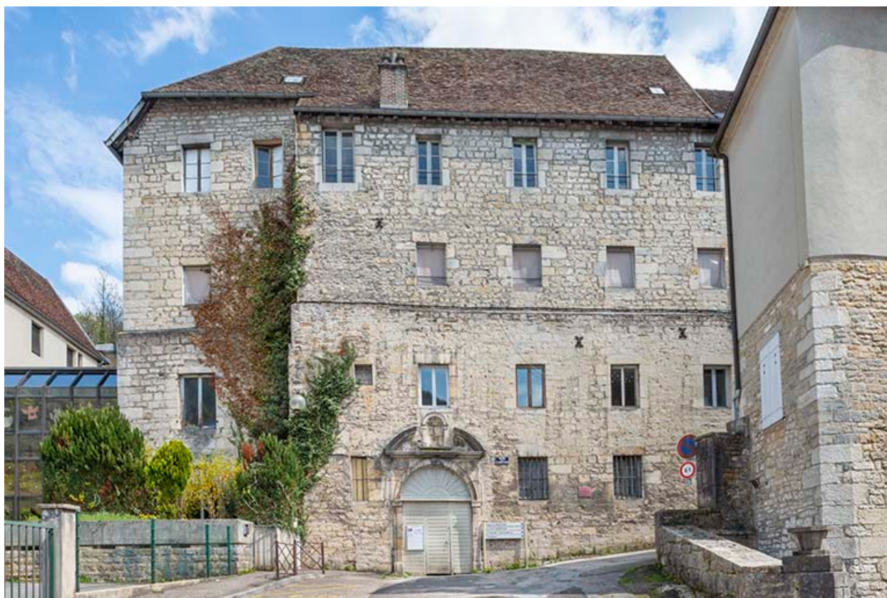
Extrémité nord du bâtiment, depuis l'ouest.
