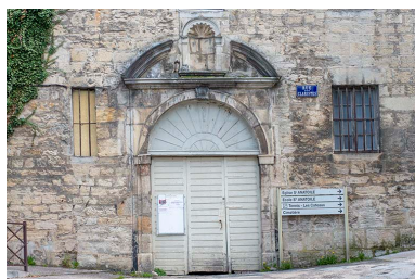
Porte principale du bâtiment sur rue. Phot. Jérôme Mongreville IVR43_20233900195NUC4A
