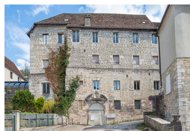
Extrémité nord du bâtiment, depuis l'ouest. Phot. Jérôme Mongreville IVR43_20233900198NUC4A
