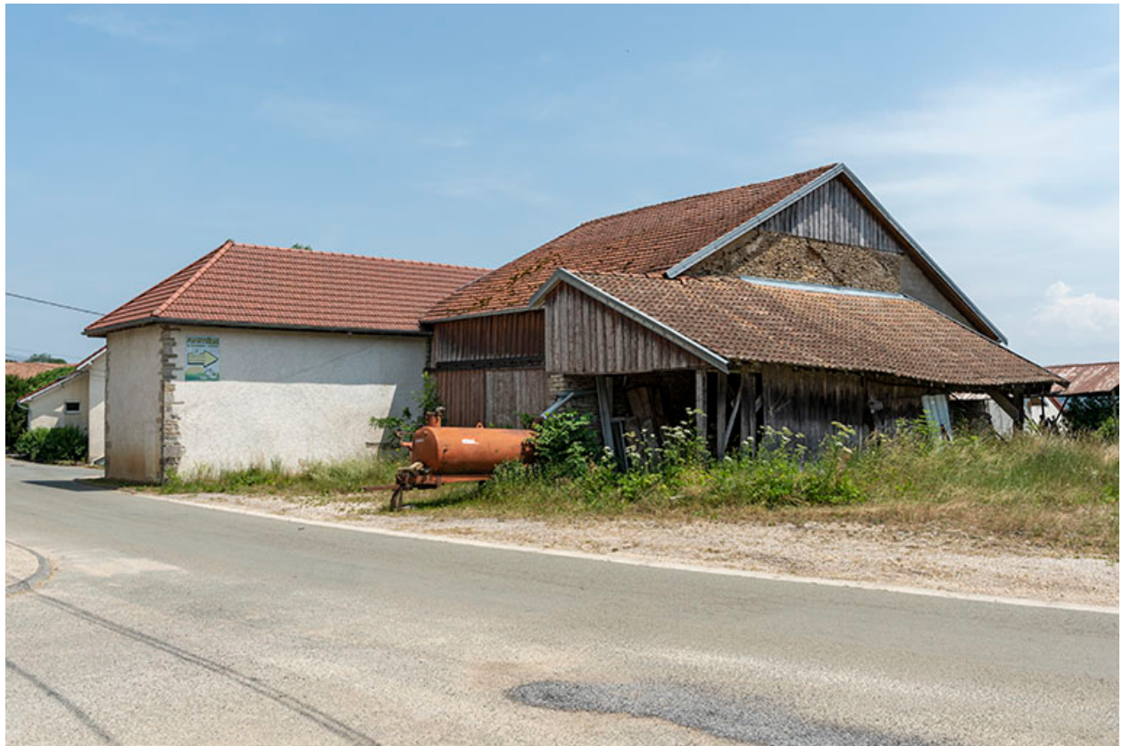
Cave d'affinage (façade postérieure), grange et hangar.
