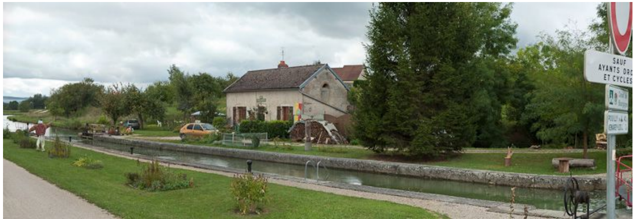
Vue d'ensemble du site d'écluse.
