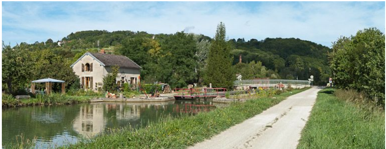
Vue du site d'écluse depuis l'amont.
