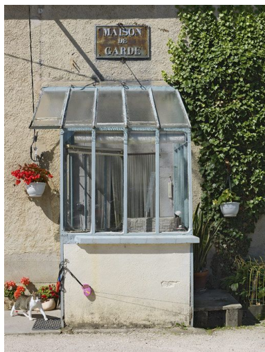
Détail : porte d'entrée et plaque. Phot. Thierry Kuntz IVR26_20112103170NUC4A
