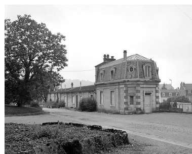
Chai et logement ouest. Phot. Yves Sancey IVR43_19833900130X
