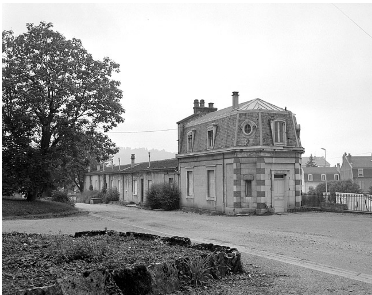
Chai et logement ouest.
