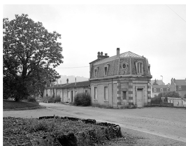
Chai et logement ouest. Phot. Yves Sancey IVR43_19833900130X
