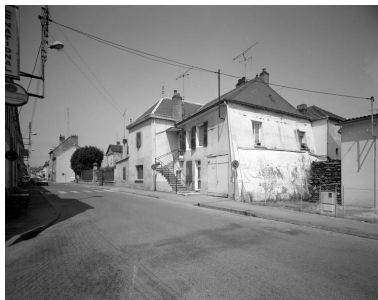
Partie droite de trois quarts droit. Phot. Yves Sancey IVR43_19897000389V
