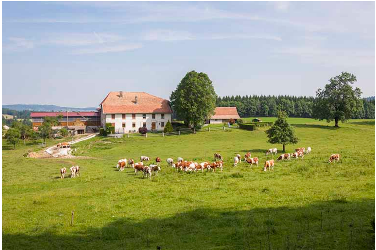
Vue d'ensemble rapprochée, depuis le sud.
