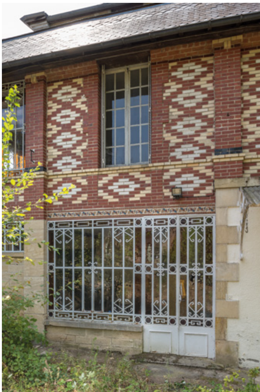
Élévation de l'extension en brique, côté nord.
