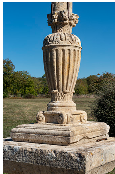
Base composée d'éléments de remploi. Phot. Jérôme Mongreville IVR43_20187000663NUC4A
