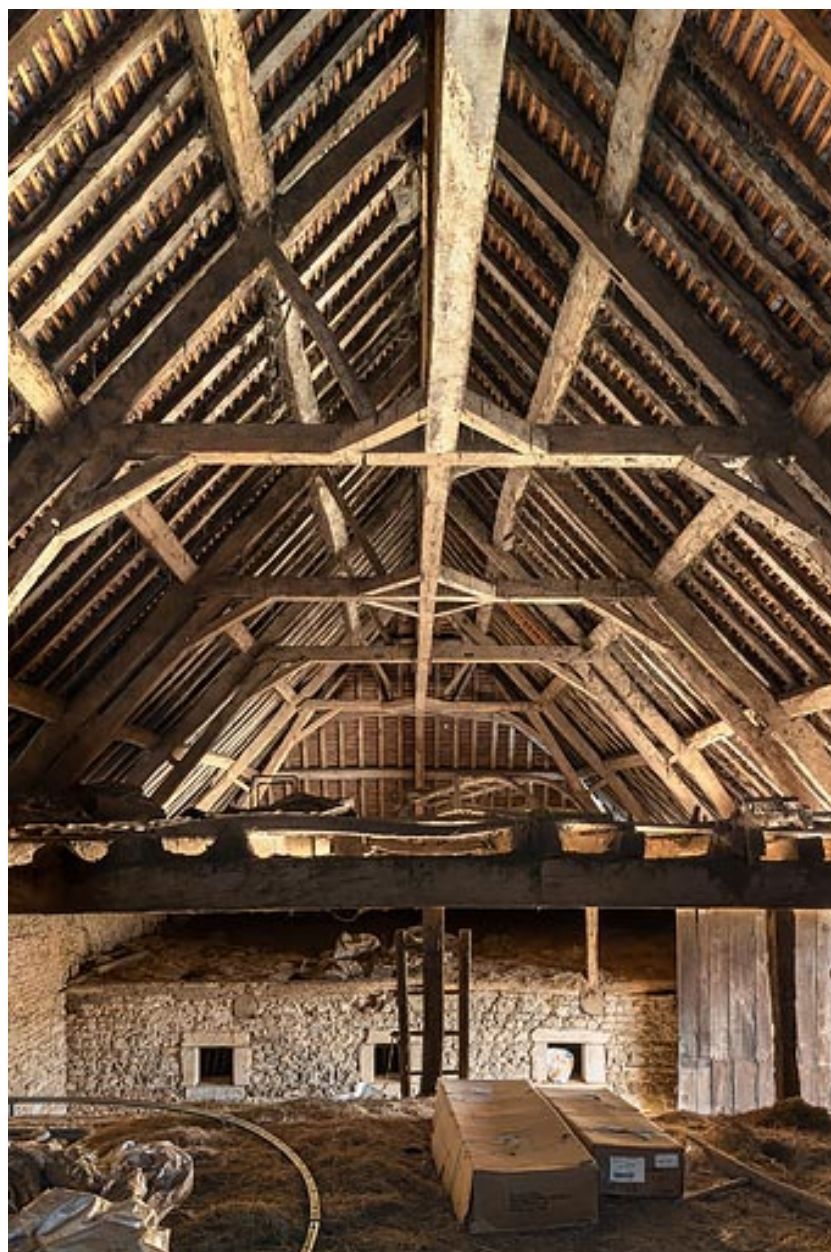
Charpente et fenil de la grange
