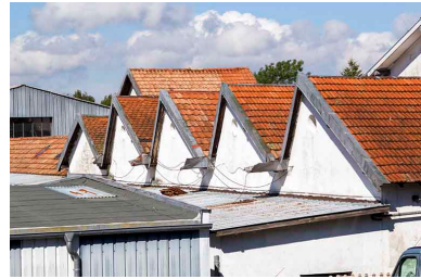
Toits en shed de l'atelier de fabrication à l'ouest du bâtiment Bourgeois. Phot. Yves Sancey IVR43_20132501070NUC2A
