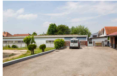
Atelier de réparation. Phot. Yves Sancey IVR43_20132501074NUC2A
