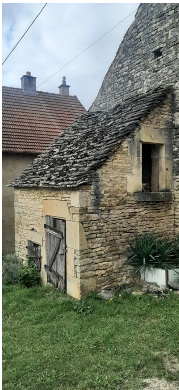
Vue du mur pignon et de la rive du toit en laves.
