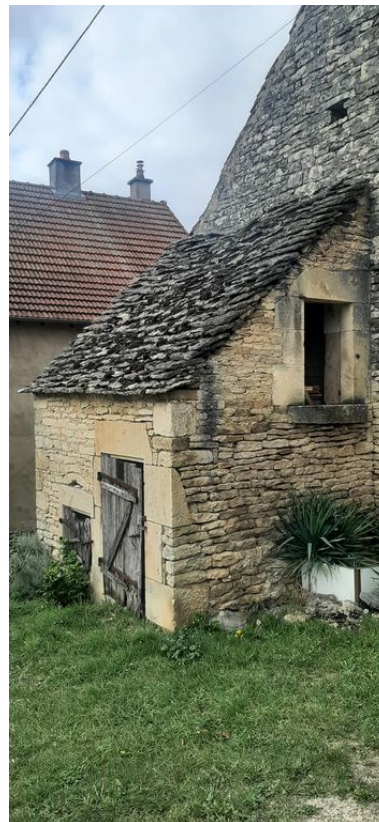
Vue du mur pignon et de la rive du toit en laves. Phot. Baptiste Quost IVR26_20242100072NUCA
