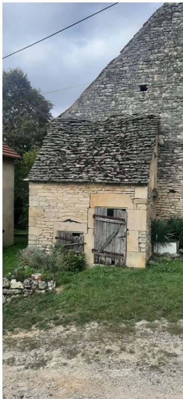
Vue de la construction depuis le sud. Phot. Baptiste Quost IVR26_20242100071NUCA
