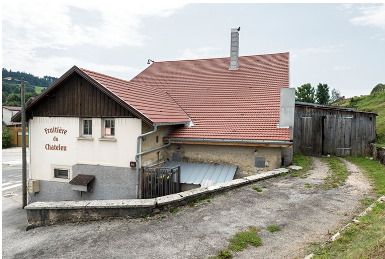
Façade latérale droite.
