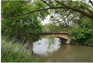
Vue d'ensemble du pont. Phot. Jean-Luc Duthu IVR26_20107100473NUC2A
