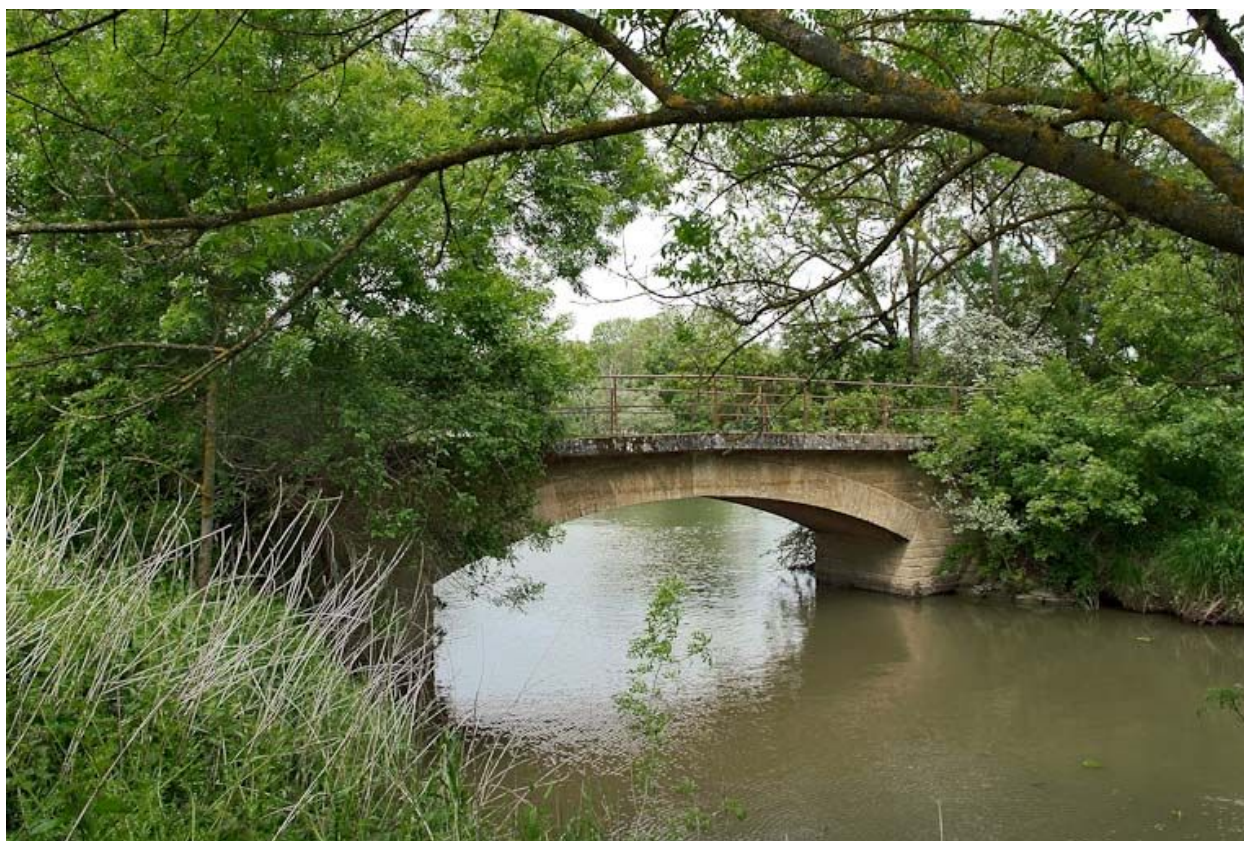
Vue d'ensemble du pont.
