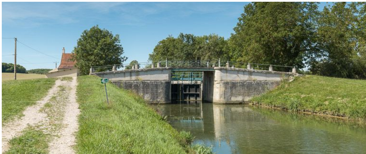
Le pont, vu d'aval.
