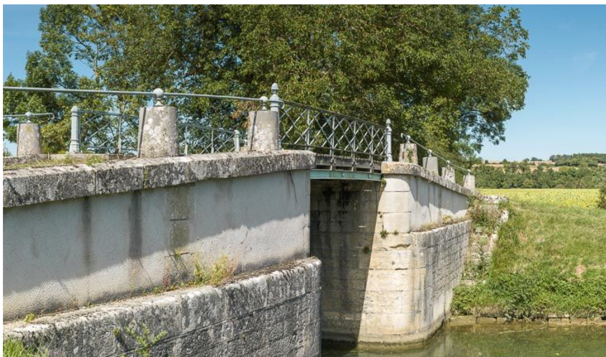
Le pont, pris d'aval.
