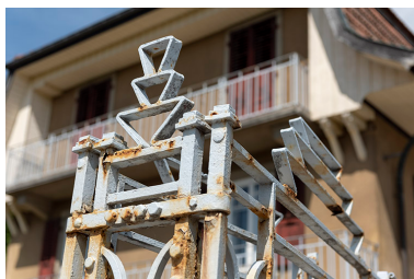
Détail de ferronnerie : couronnement du pilier. Phot. Sonia Dourlot IVR43_20182501038NUC4A
