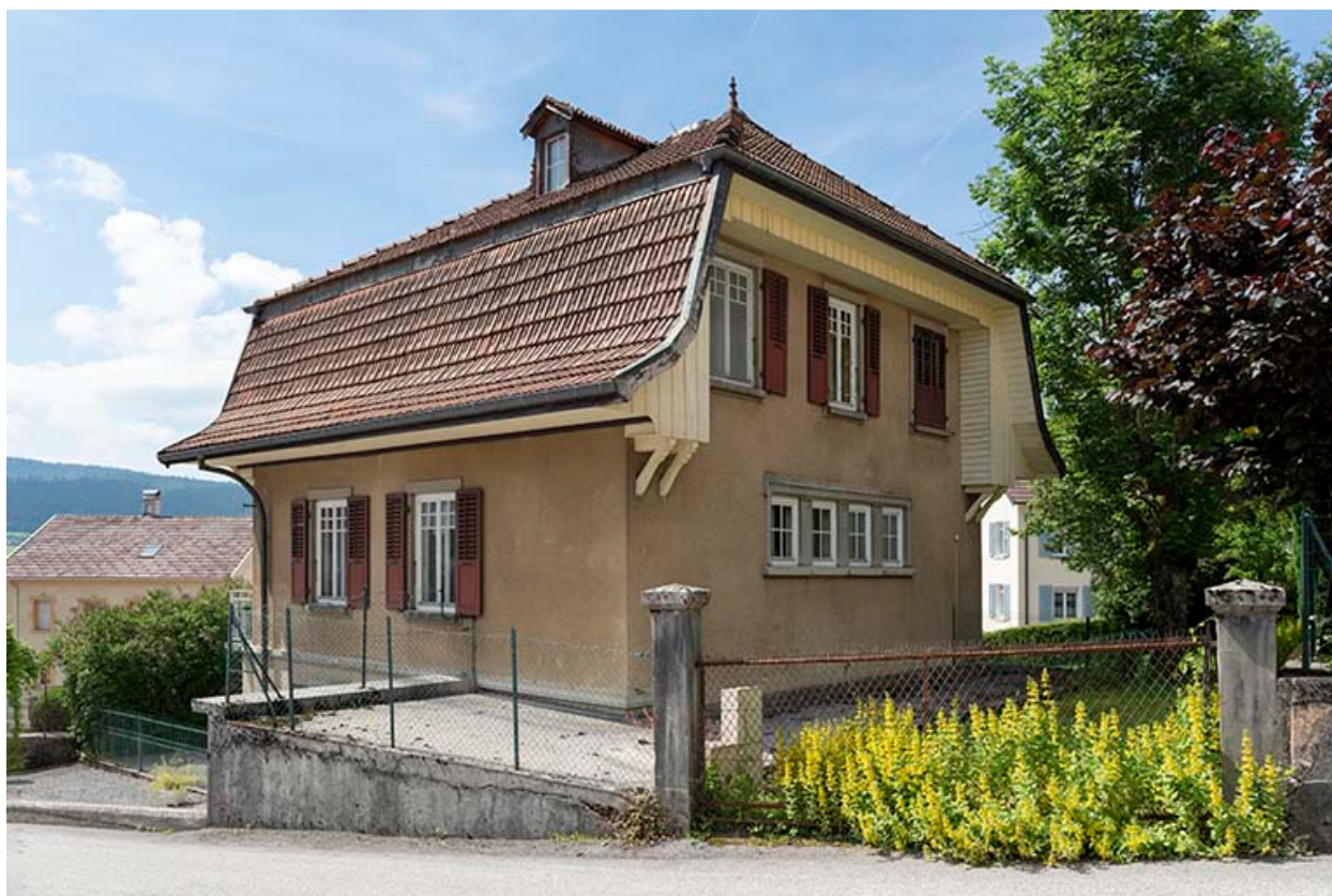
Façades postérieure et latérale droite.
