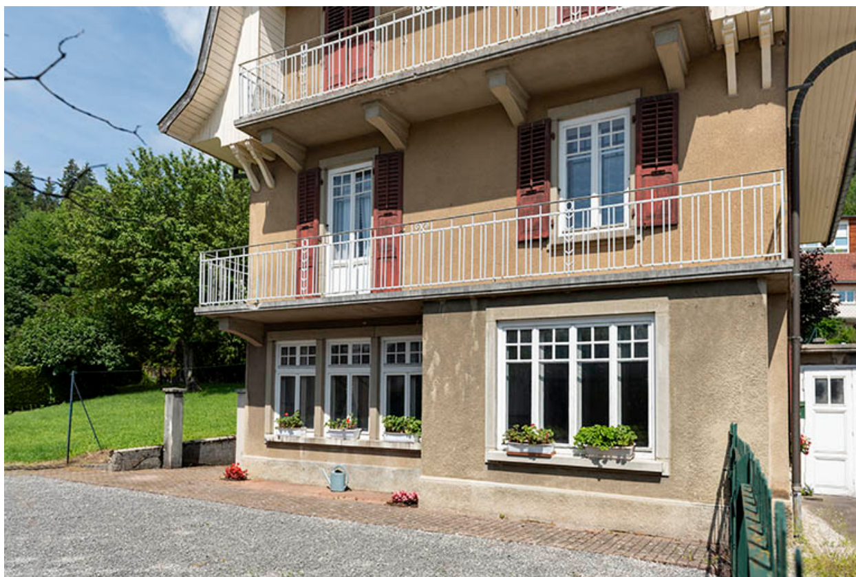
Façade antérieure : rez-de-chaussée et 1er étage.
