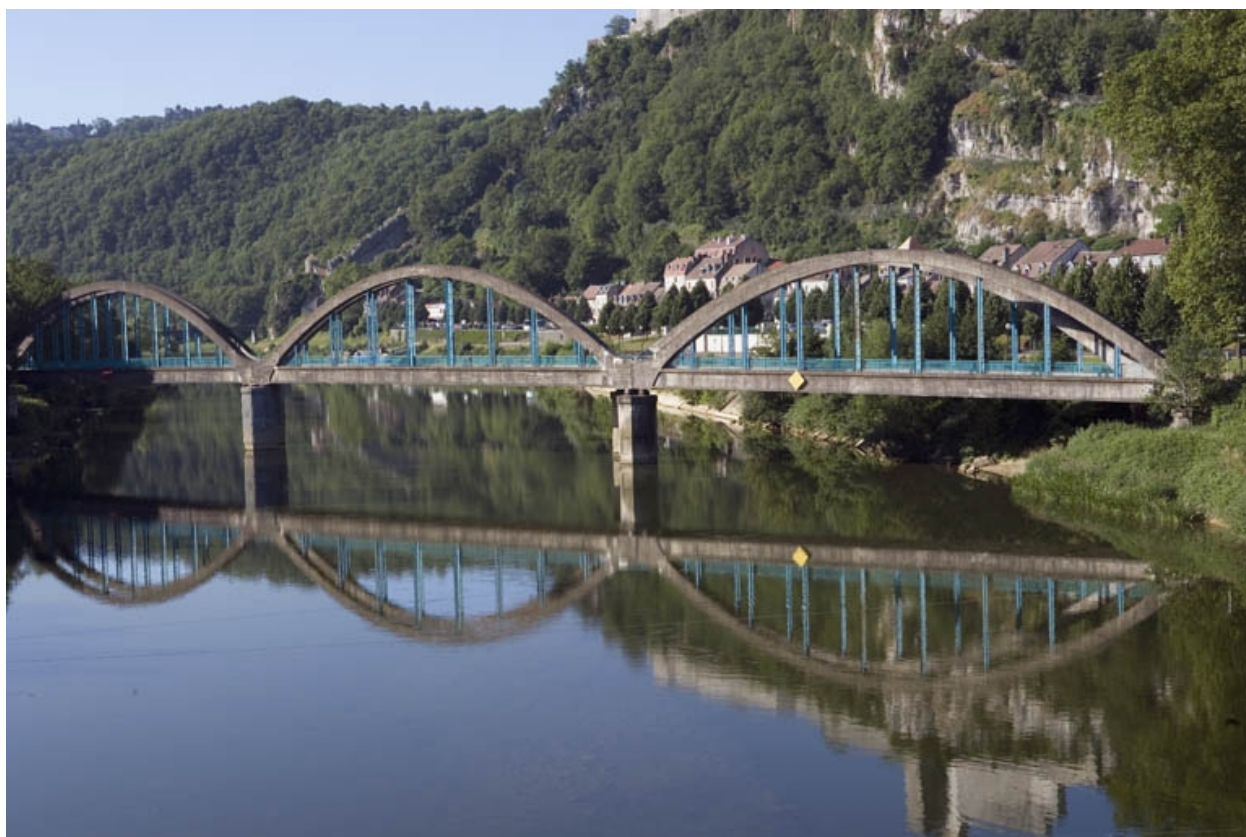
Vue d'ensemble rapprochée depuis l'aval.
