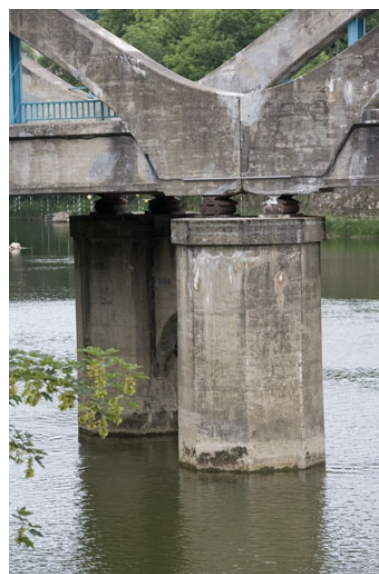
Piles côté rive gauche. Phot. Yves Sancey IVR43_20062500311NUCA
