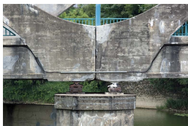
Doubles rotules supportant le tablier (piles côté rive gauche). Phot. Yves Sancey IVR43_20062500310NUCA
