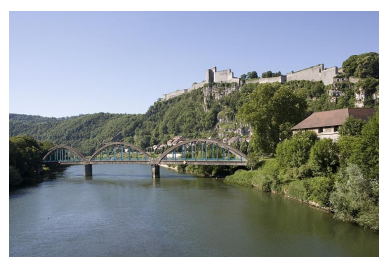
Vue d'ensemble depuis l'aval. Phot. Yves Sancey IVR43_20062500164NUCA
