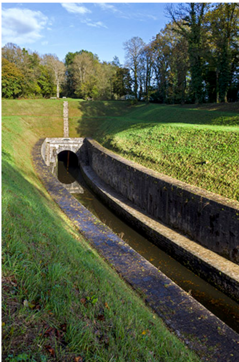
Entrée du tunnel depuis l'aval.
