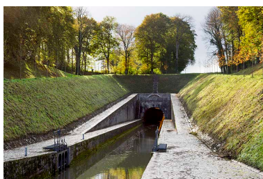
Le canal et le tunnel, vue amont. Phot. Sonia Dourlot IVR43_20157000206NUC2A
