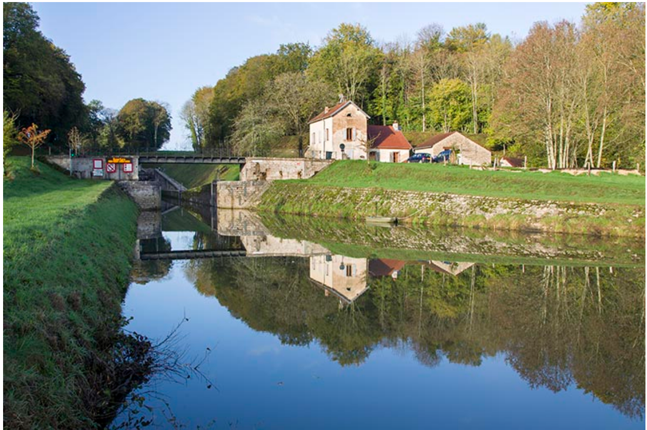
Entrée du canal depuis l'amont.
