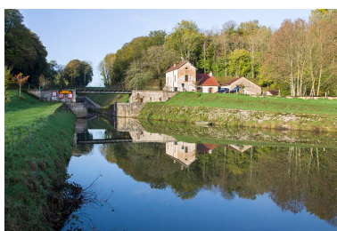
Entrée du canal depuis l'amont. Phot. Sonia Dourlot IVR43_20157000202NUC2A
