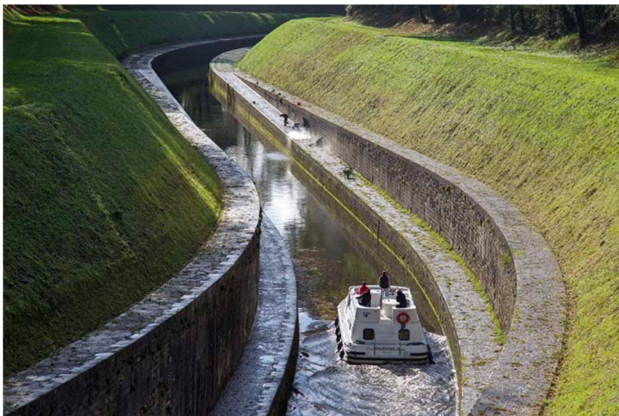
Le canal en aval formant un S.
