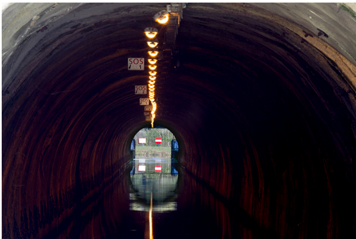
Le tunnel, vue intérieure.
