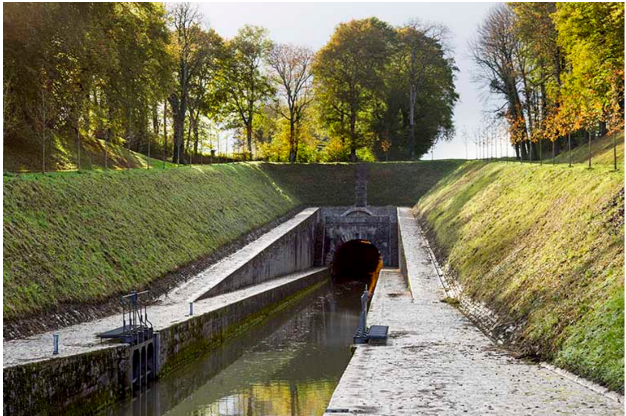
Le canal et le tunnel, vue amont.
