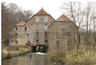
Vue rapprochée depuis l'aval du bief. Phot. Jérôme Mongreville IVR43_20097000232NUC2A
