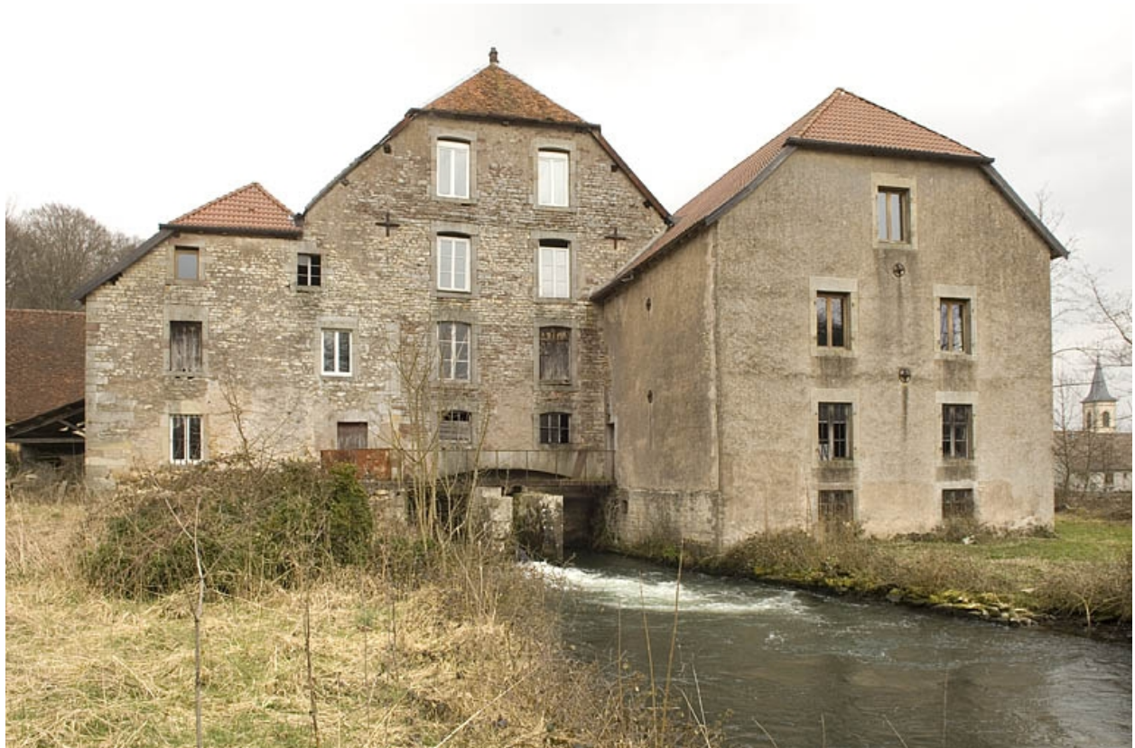
Vue rapprochée depuis la rive droite.
