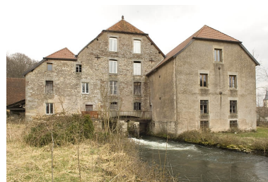
Vue rapprochée depuis la rive droite. Phot. Jérôme Mongreville IVR43_20097000238NUC2A
