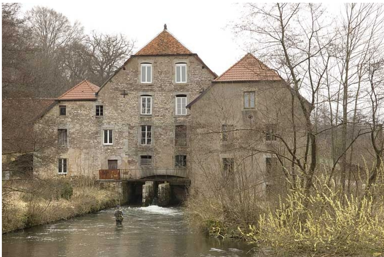
Vue rapprochée depuis l'aval du bief.
