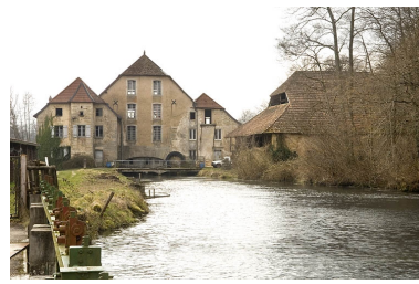
Vue d'ensemble depuis l'amont. Phot. Jérôme Mongreville IVR43_20097000240NUC2A
