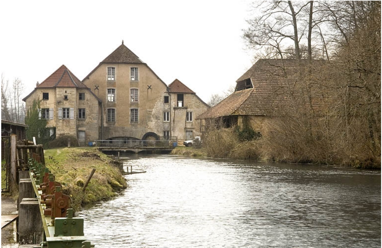
Vue d'ensemble depuis l'amont.
