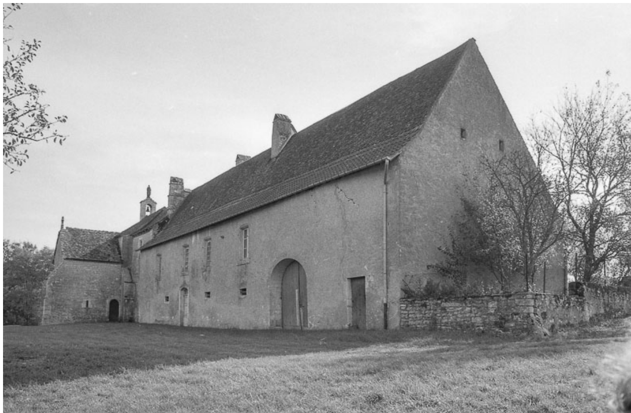
Bâtiment annexe, façade antérieure.
