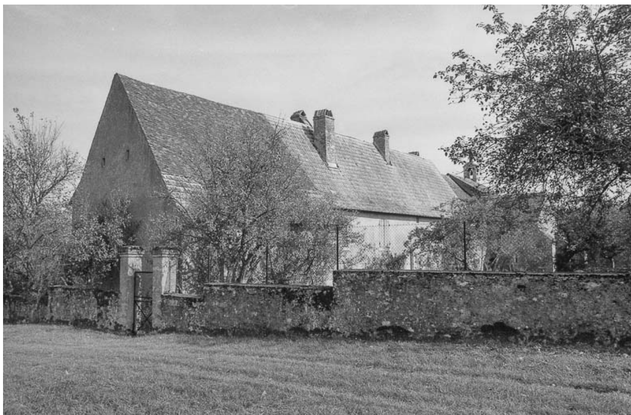
Bâtiment annexe, façade postérieure sur jardin.
