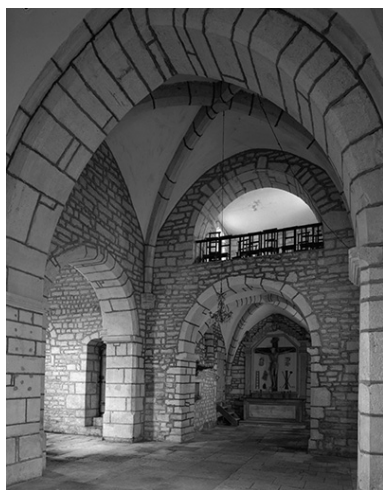
Intérieur : nef et tribunes. Phot. Yves Sancey IVR43_19777000026V
