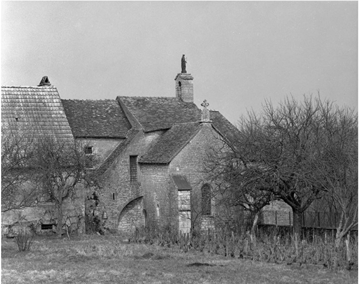
Façade latérale droite.
