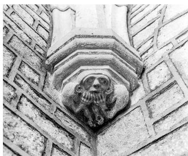
Intérieur : détail culot. Phot. Yves Sancey IVR43_19777000147X
