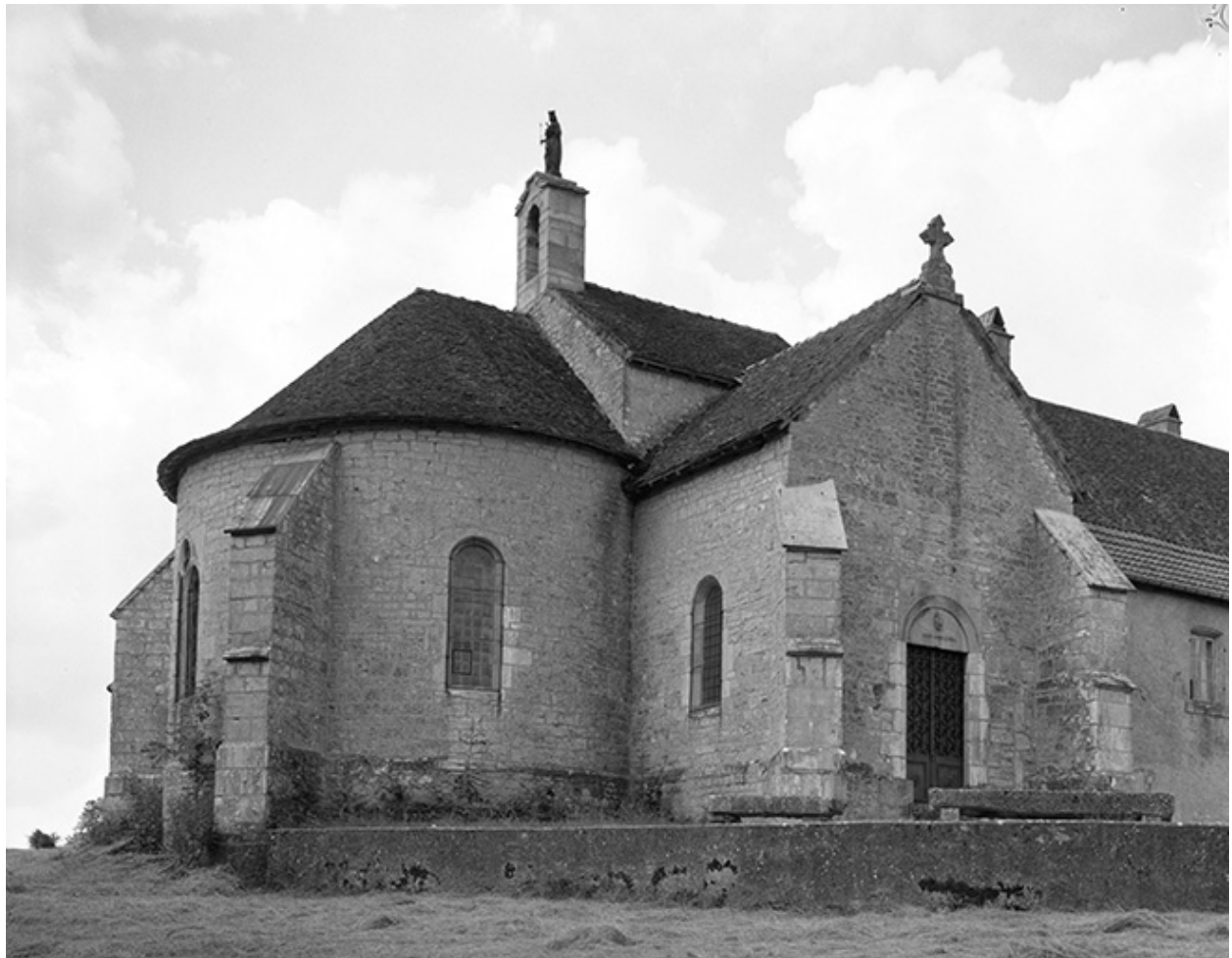
Extérieur : chœur et façade latérale gauche.
