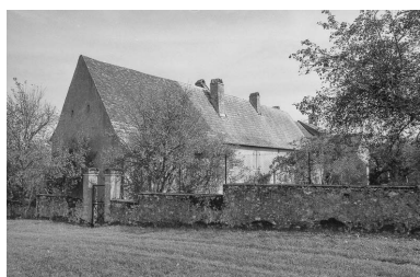
Bâtiment annexe, façade postérieure sur jardin. Phot. Bernard Lardière IVR43_19797000192Z
