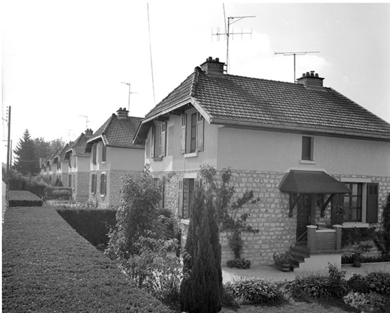
Maisons de type 10A, rue de Belvoie.
