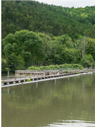
Vue du barrage.
