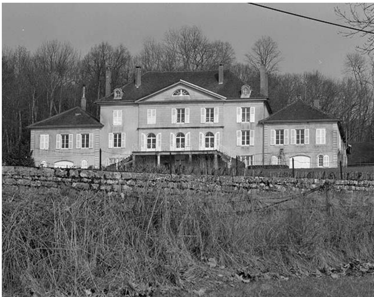
Façade antérieure vue de face.
