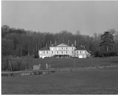
Vue de situation. Phot. Jérôme Mongreville IVR43_19853900065X
