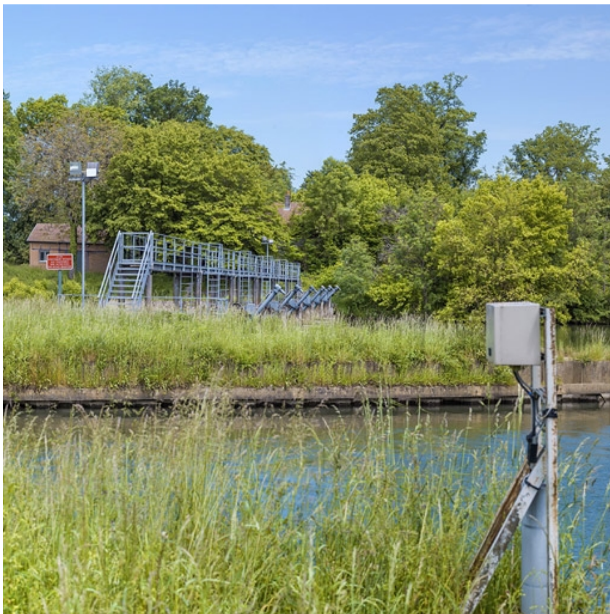
Les vérins du barrage.
