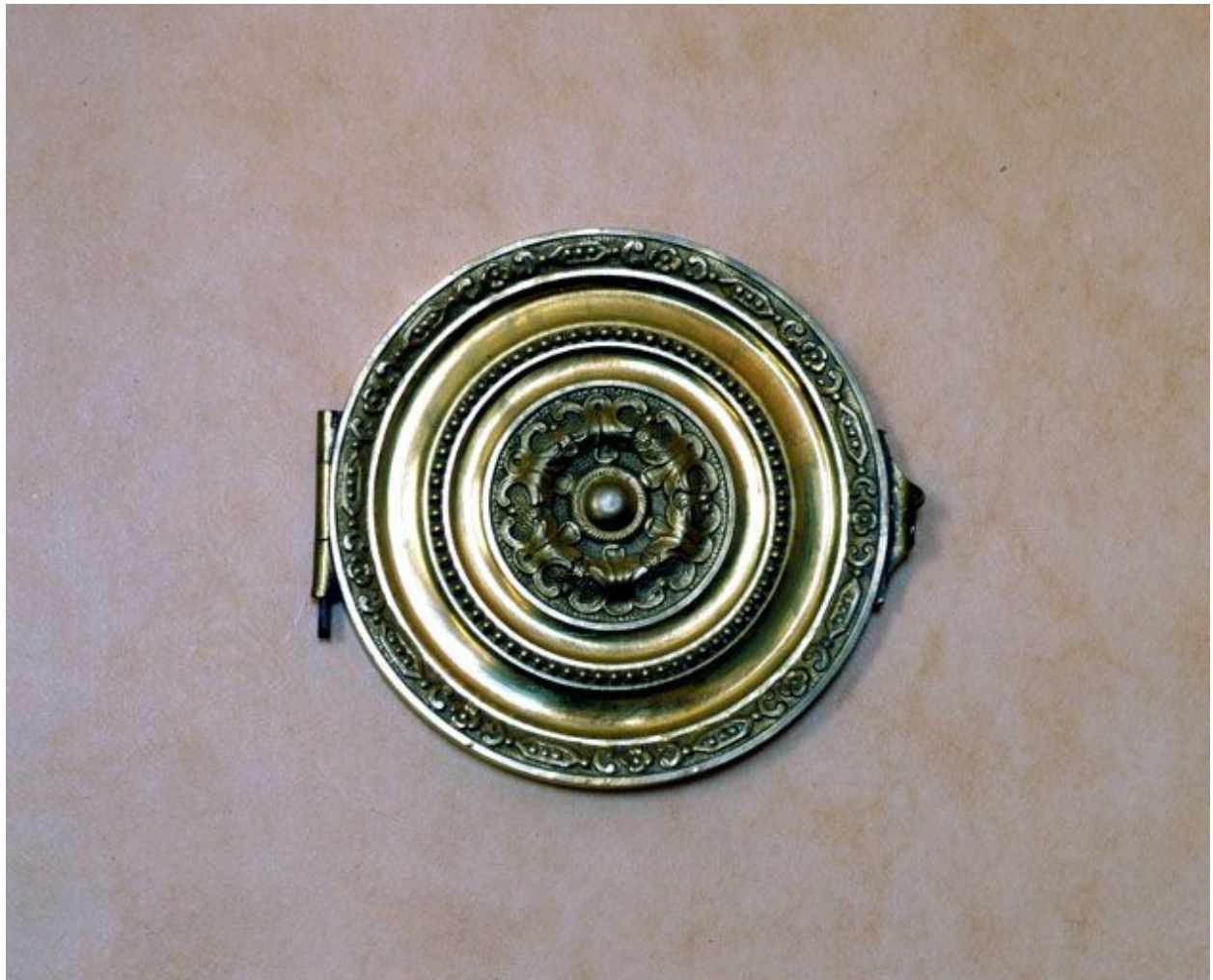
Bouche de chaleur de la cheminée, fermée.
