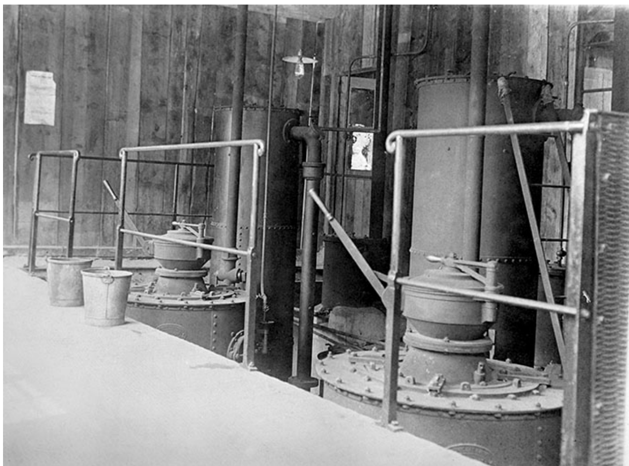
Suction Gas Producers [Gazogène à aspiration en 1910].
