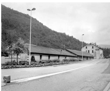
Entrepôts et logement. Phot. Jérôme Mongreville IVR43_19923900492X
