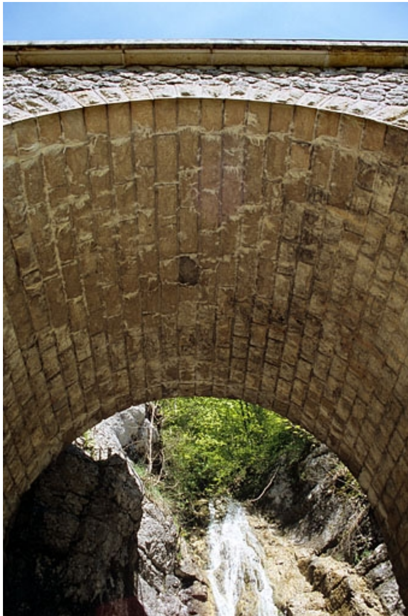
Viaduc : arche, vue du dessous.
