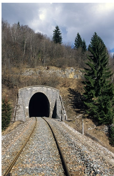
Tunnel : tête côté La Cluse (ouest).
