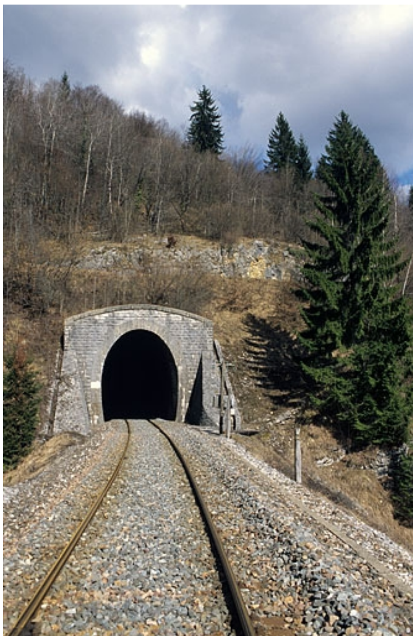
Tunnel : tête côté La Cluse (ouest).
