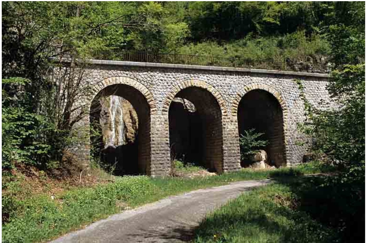
Viaduc, vu de trois quarts gauche.
