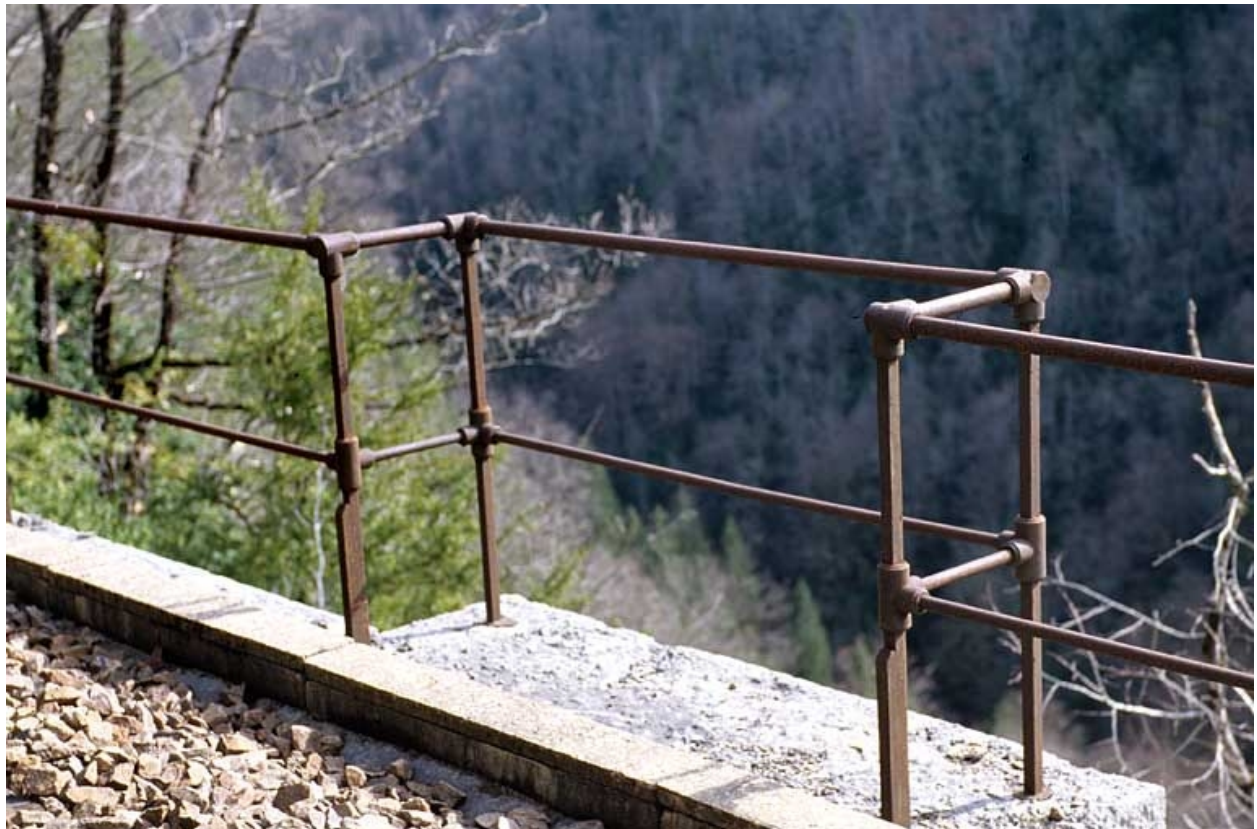
Mur : garde-corps métallique d'un refuge.
