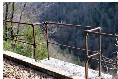
Mur : garde-corps métallique d'un refuge.
