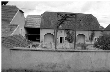
Vue du bâtiment agricole. Phot. Bernard Lardière IVR43_19817000380Z
