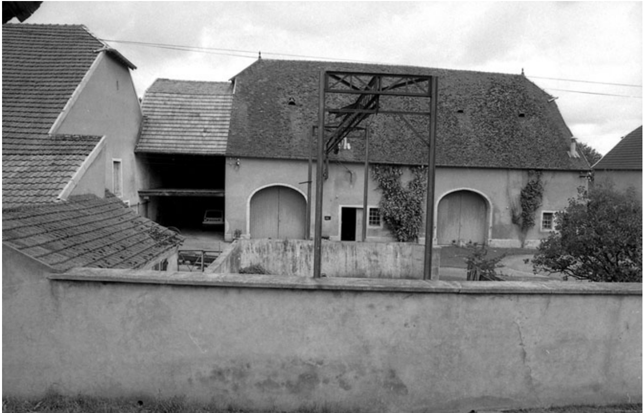
Vue du bâtiment agricole.
