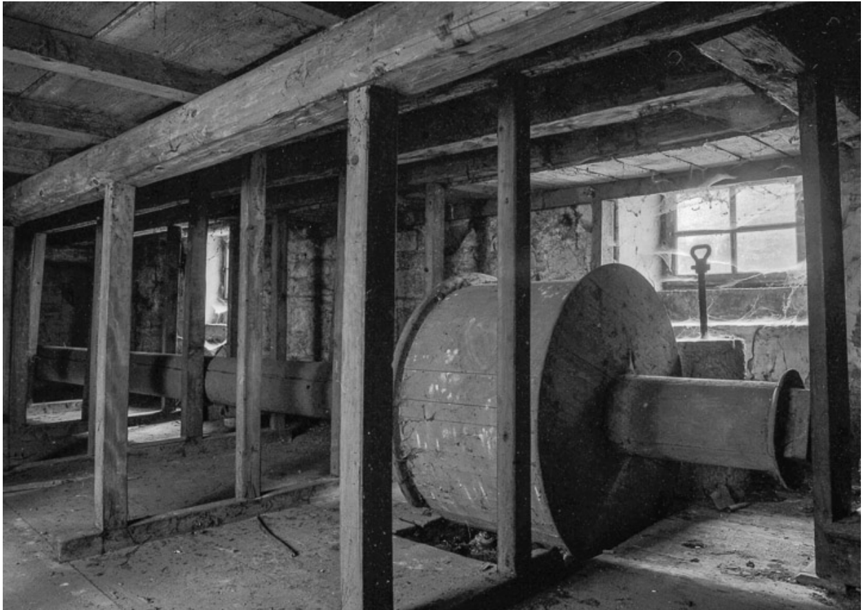
Dessous de scène. Tambour de la machinerie (1987).
