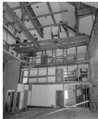
Vue des cintres (1987). Phot. Yves Sancey IVR43_19873900040X
