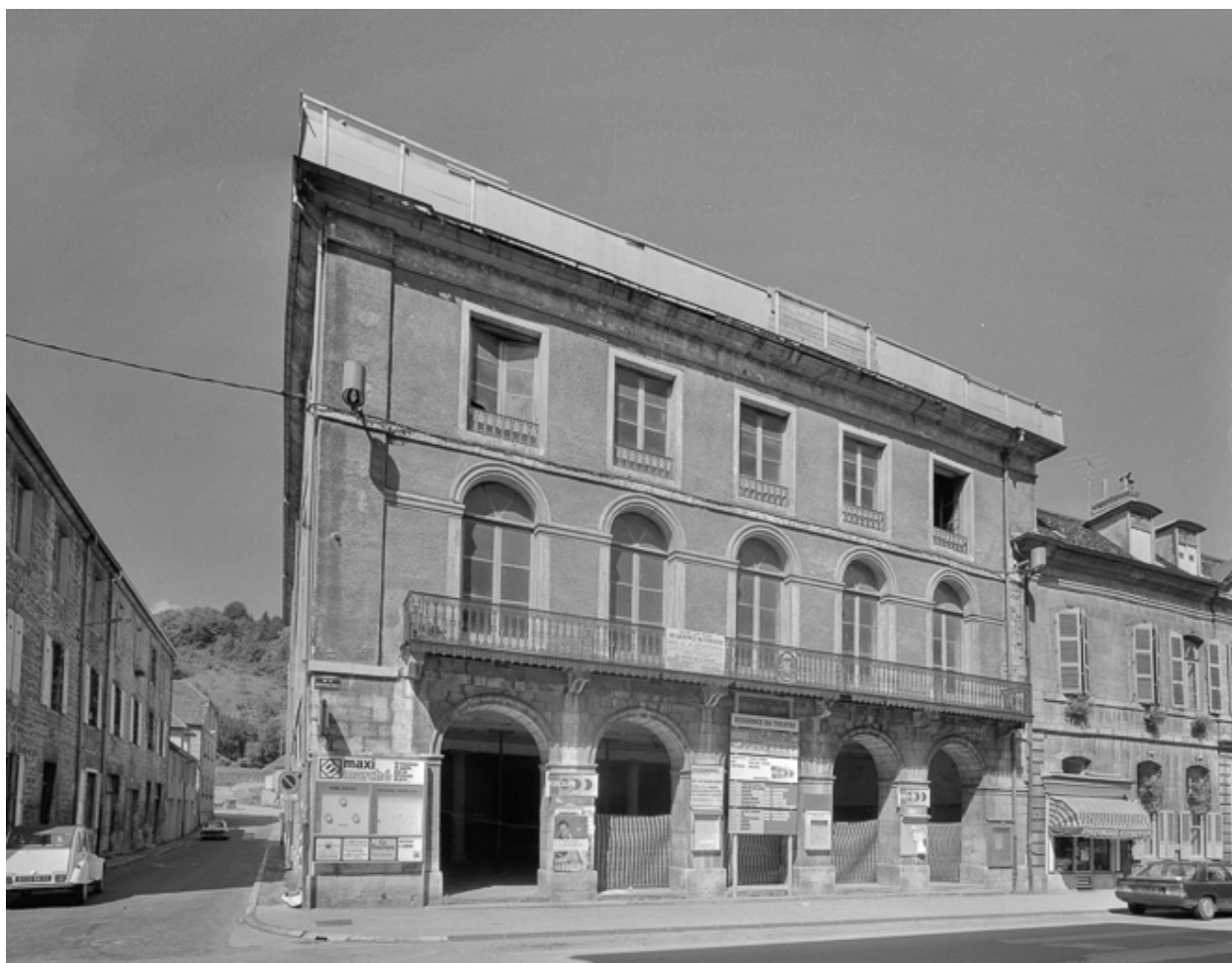
Vue de la façade est avant déconstruction (1987).
