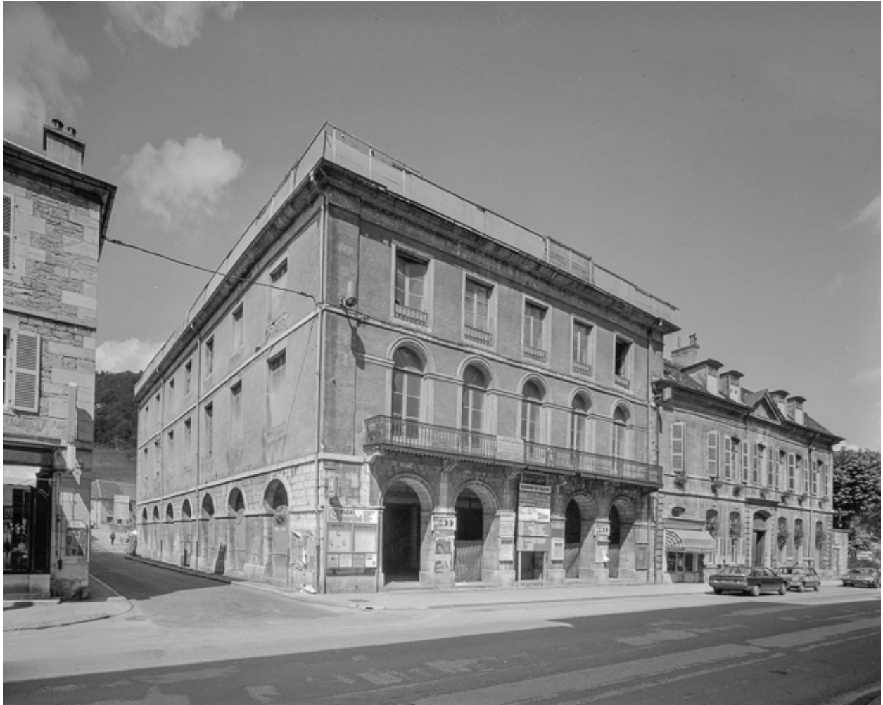
Vue avant déconstruction (1987).
