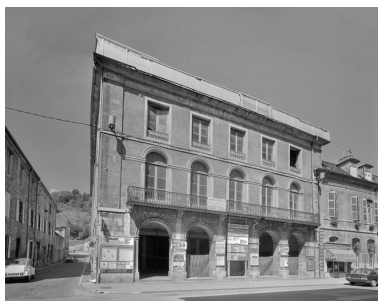
Vue de la façade est avant déconstruction (1987).
