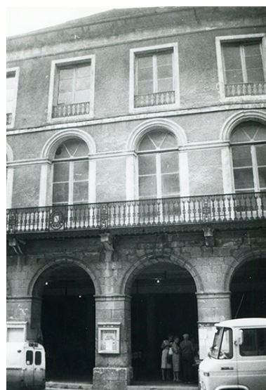
Détail de la façade antérieure, 1982. Phot. Patrick Blandin IVR43_20253900115NUC4A
