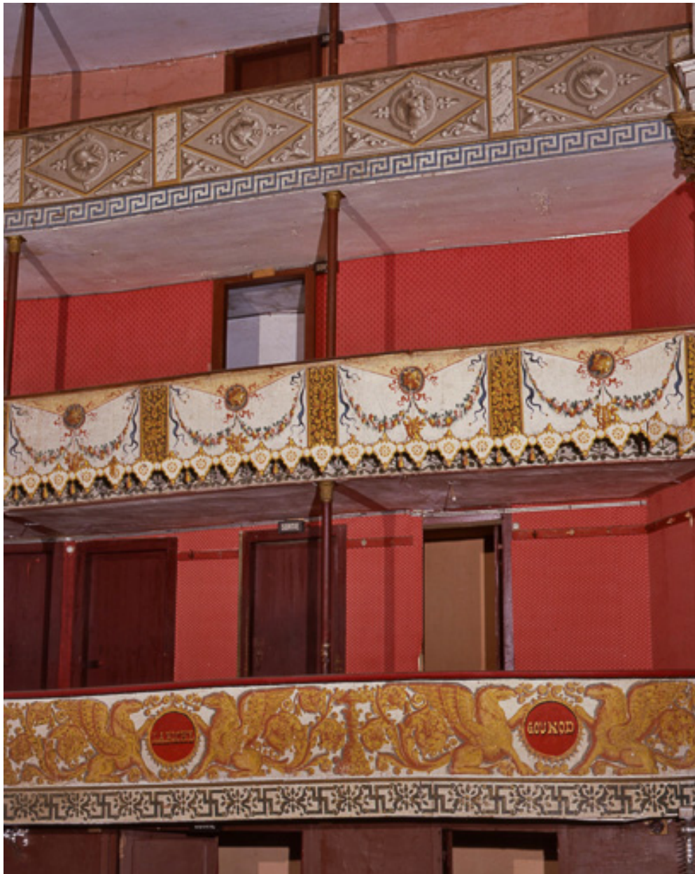
Elévation des balcons et décor peint (1987).
