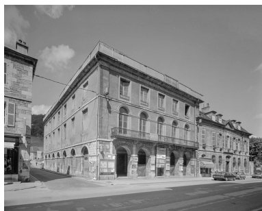
Vue avant déconstruction (1987). Phot. Yves Sancey
