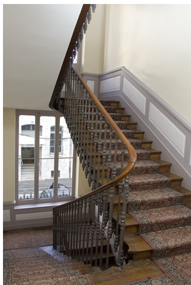
Intérieur : l'escalier. Phot. Yves Sancey IVR43_20122500606NUC2A
