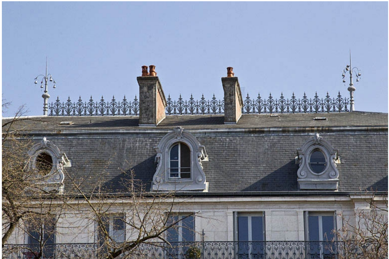
Détail de la toiture en ardoise.
