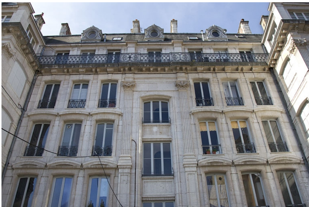
Vue de la façade postérieure.
