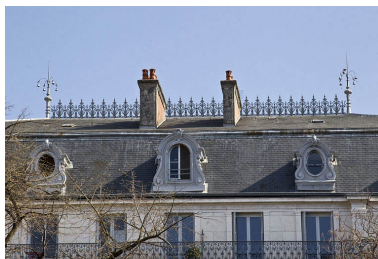
Détail de la toiture en ardoise.
