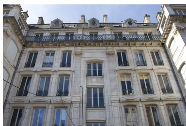
Vue de la façade postérieure. Phot. Yves Sancey IVR43_20122500612NUC2A
