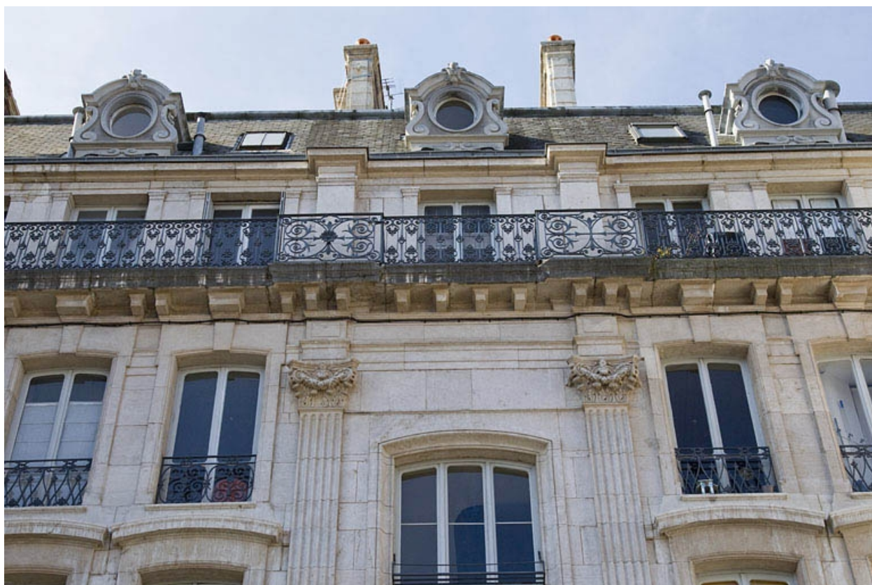
Façade antérieure : détail de la partie supérieure.
