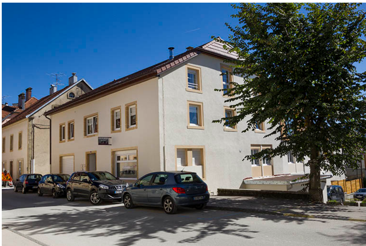
Façades antérieure et latérale droite.
