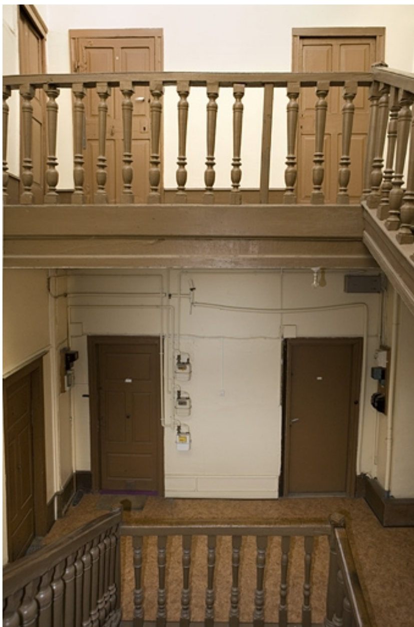
Détail de la rampe de l'escalier.
