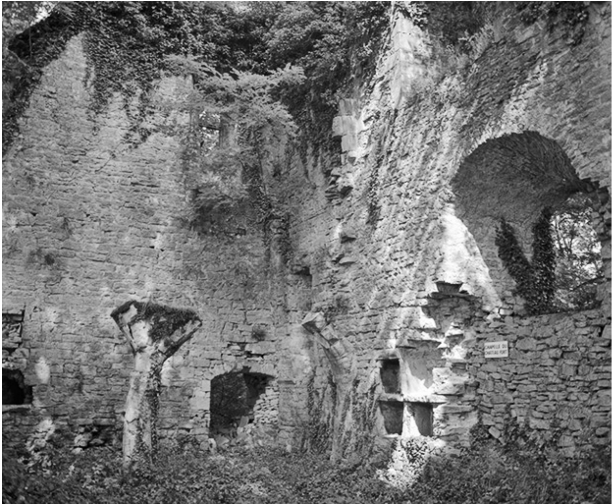
Chapelle du château, vue intérieure.
