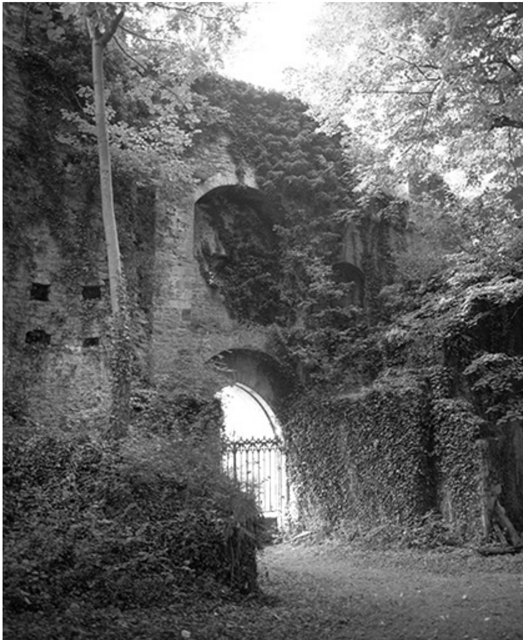
Porte de l'Epinette, vue intérieure.
