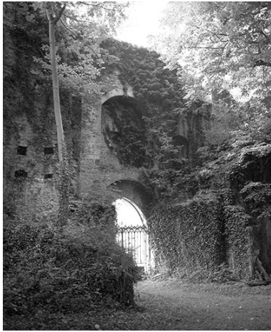
Porte de l'Epinette, vue intérieure.
