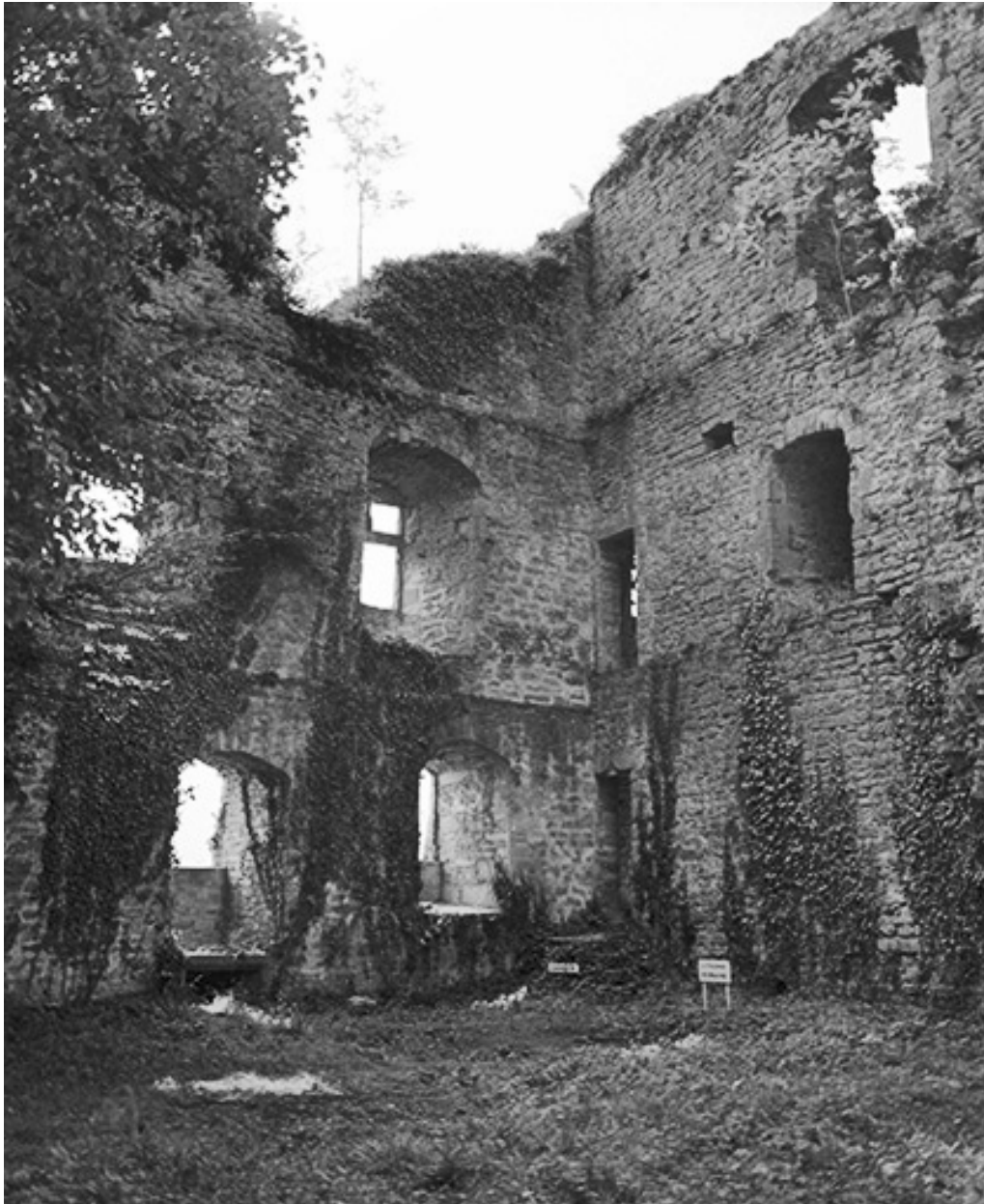
Le donjon, vue intérieure de l'angle sud-est.
