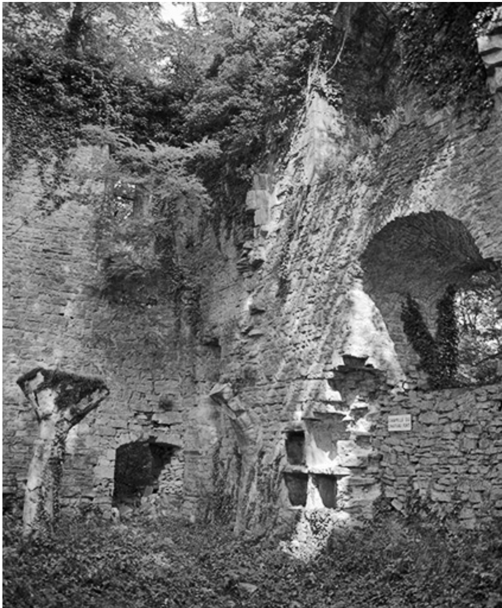
Chapelle du château, vue intérieure.
