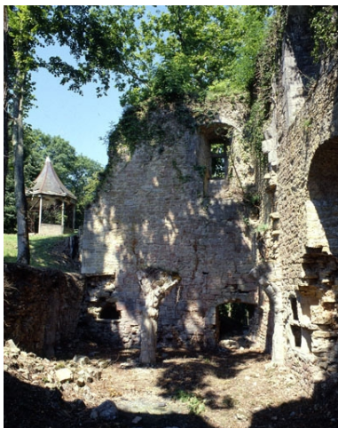
Ruines d'une chapelle, salle probablement en sous-sol, constituée de deux vaisseaux à deux travées : colonne centrale qui recevait les retombées des ogives. Phot. Yves Sancey IVR43_19903901081XA
