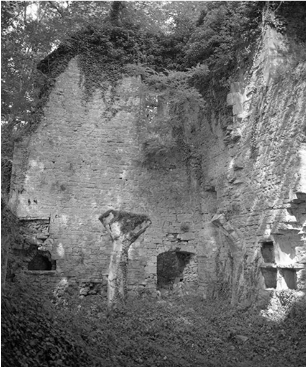
Chapelle du château, vue intérieure.
