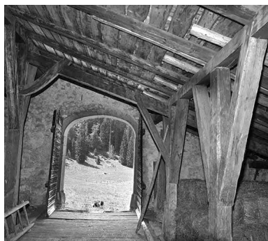
Vue intérieure de la charpente. Phot. Jérôme Mongreville IVR43_20013900472X
