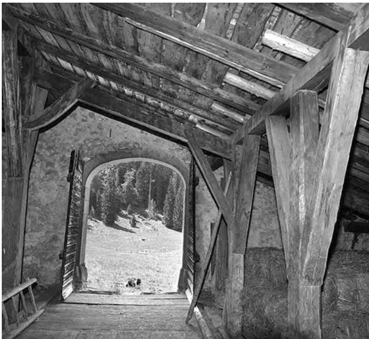
Vue intérieure de la charpente.
