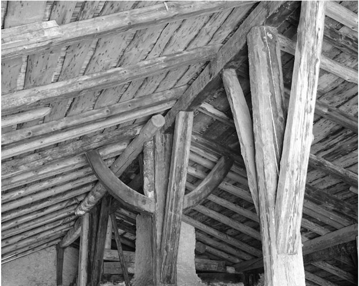
Charpente, colonne sous faîtage et contrefiche.
