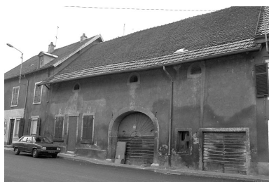
Audincourt : ferme située 1 rue Albert Parrot. Phot. Bernard Lardière IVR43_19832500157Z
