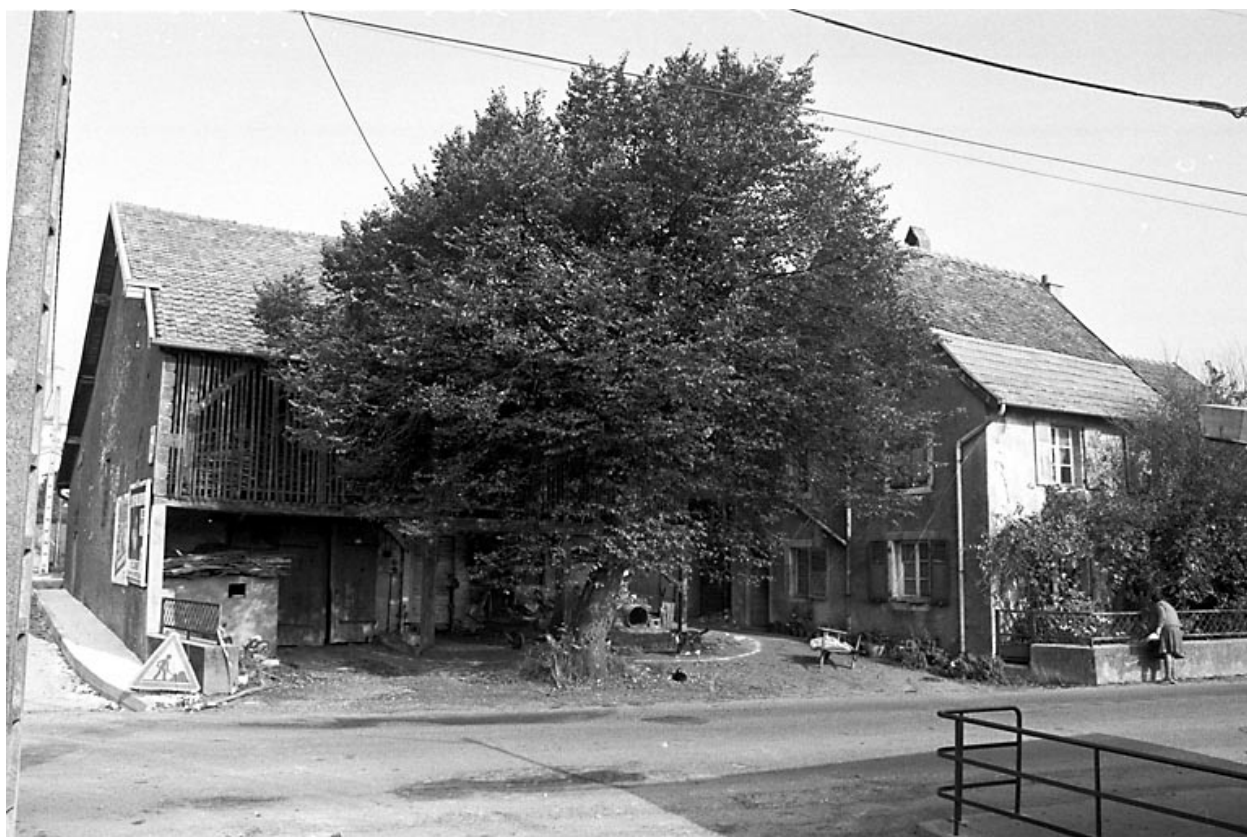
Taillecourt : ferme située Grande Rue.
