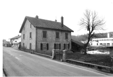
Audincourt : maison située 124 rue des Mines. Phot. Bernard Lardière IVR43_19832500243Z
