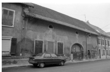
Audincourt : ferme située 1 rue Albert Parrot. Phot. Bernard Lardière IVR43_19832500156Z
