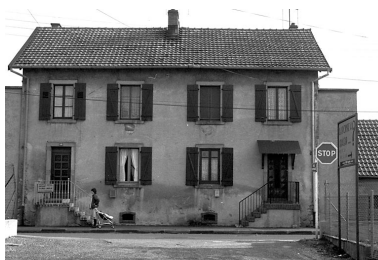
Audincourt : maison située 65 rue des Mines. Phot. Bernard Lardière IVR43_19832500267Z
