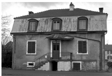
Audincourt : maison située 5 rue de Soissons. Phot. Bernard Lardière IVR43_19832500216Z
