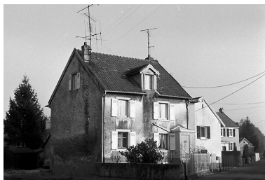
Audincourt : maison située 42 rue de Champagne. Phot. Bernard Lardière IVR43_19832500200Z
