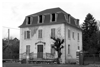
Audincourt : maison située 85 rue de Seloncourt. Phot. Bernard Lardière IVR43_19832500214Z
