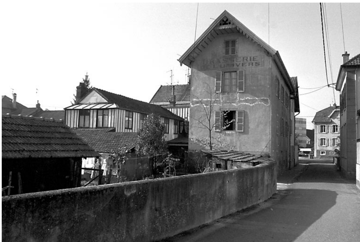
Audincourt : maison située 17 rue Neuve.
