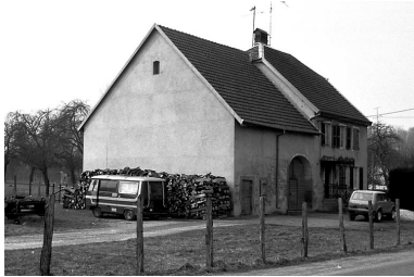
Dasle : ferme située rue de Seloncourt. Phot. Bernard Lardière IVR43_19832500365Z
