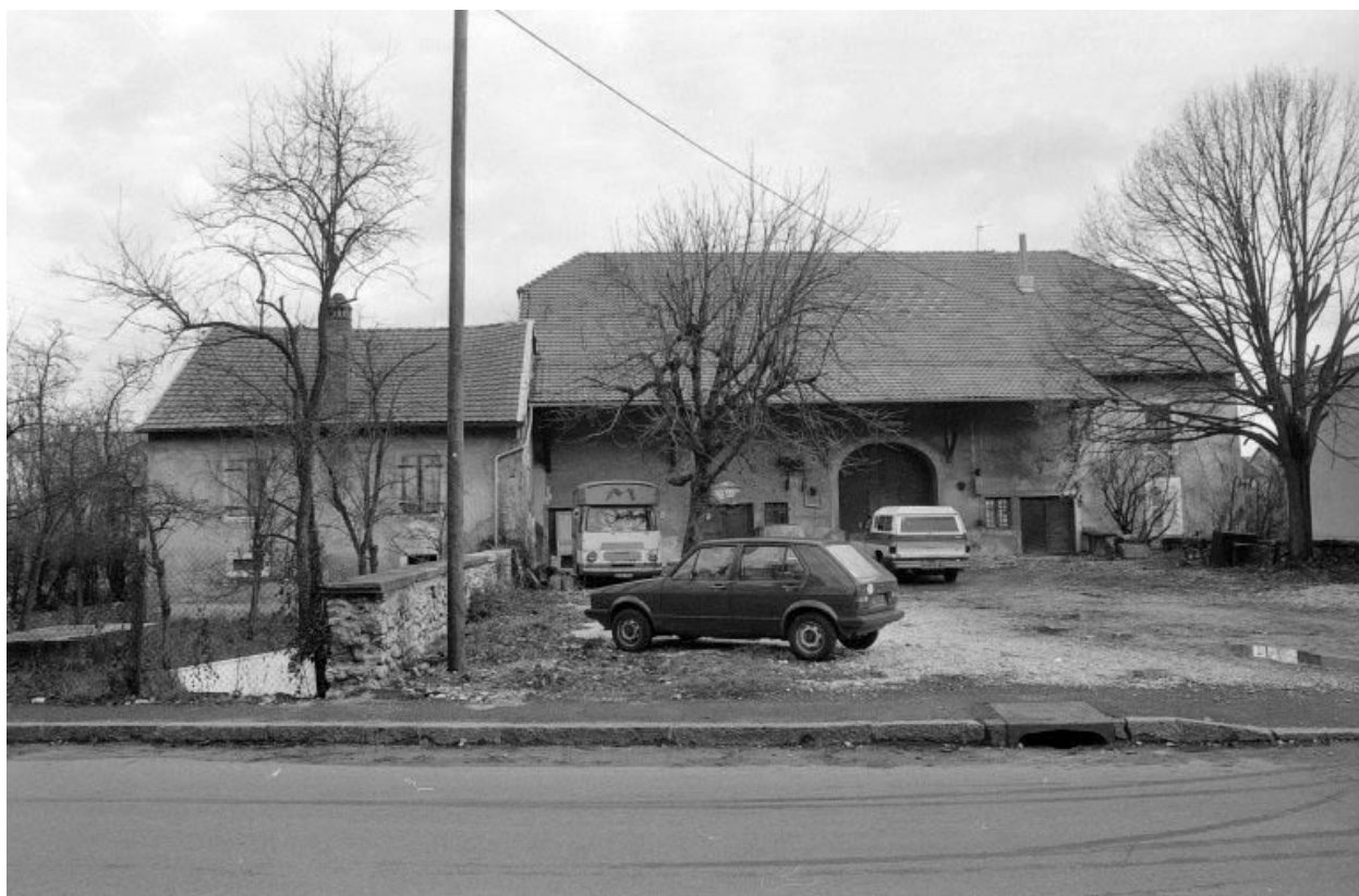
Audincourt : ferme située 9 rue de Valentigney.
