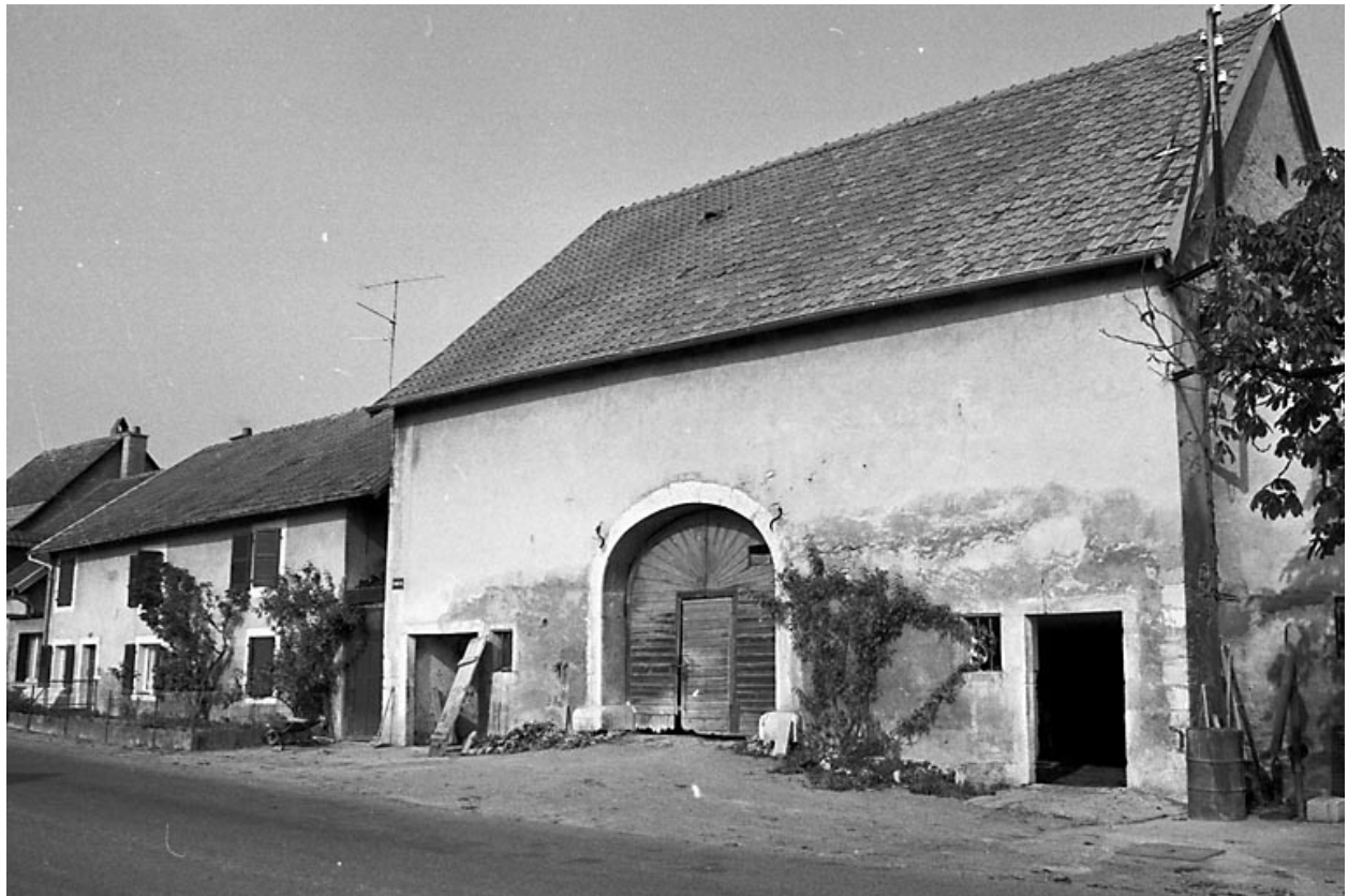
Taillecourt : ferme située Grande Rue.
