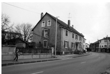
Audincourt : maison située 37 rue de Seloncourt. Phot. Bernard Lardière IVR43_19832500229Z
