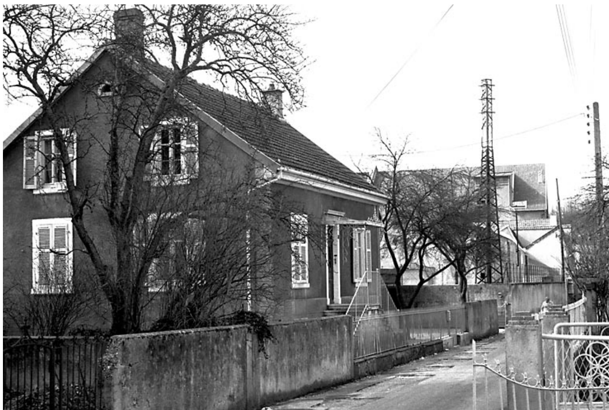
Audincourt : maison située 5 rue des Serruriers.
