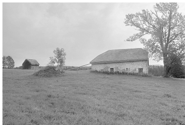
Vue générale, ferme et grenier fort. Phot. Jérôme Mongreville IVR43_19963901326X
