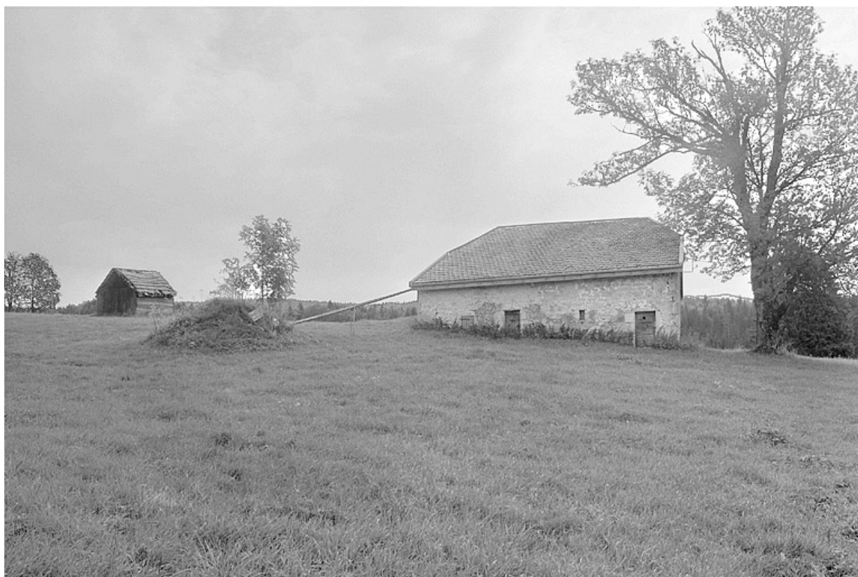
Vue générale, ferme et grenier fort.
