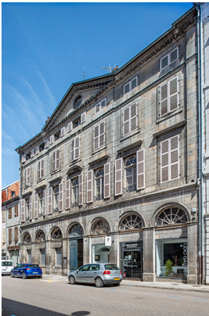
Facade antérieure vue de trois quarts droite.
