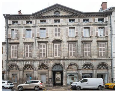
Façade antérieure. Phot. Jérôme Mongreville IVR43_20243901070NUC4A
