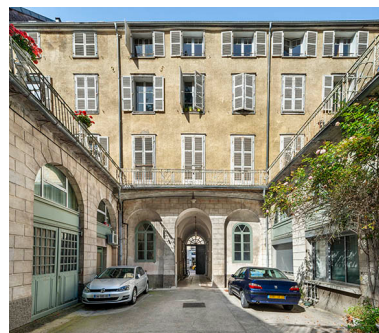
Façade postérieure vue depuis la cour. Phot. Jérôme Mongreville IVR43_20233900824NUC4A
