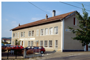
Bureau. Phot. Laurent Poupard IVR43_19913901097ZA
